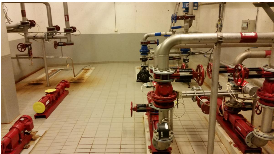
Figur 4. Mulig plassering av slampumper i pumpekjeller.
