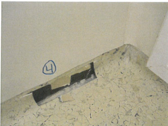
Foto 2: Prøve 4 av gulvbelegg i operasjonsrom viser innhold av mindre mengder tungmetaller og ftalater over grense for farlig avfall
