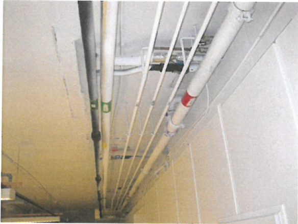
Foto 5: Cellegummi benyttet som rørisolasjon rives på vanlig måte med sorteres som egen fraksjon og leveres som farlig avfall.
