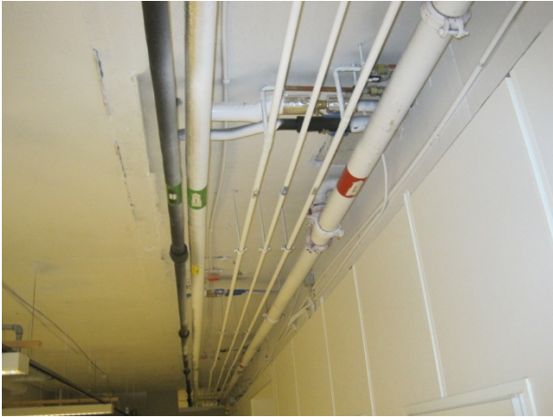
Foto 5: Cellegummi benyttet som rørisolasjon rives på vanlig måte med sorteres som egen fraksjon og leveres som farlig avfall.
