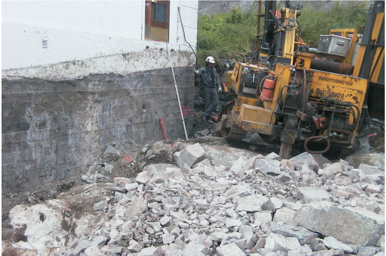
2005-07-13 Hjørne nordøst A, mot nordvest. Dør i 3. etg.
