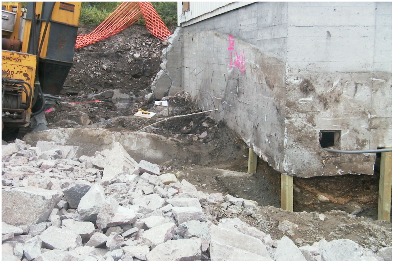
2005-07-13 Hjørne sørvest bibliotekbrakke, mot nord. Støttet før understøp.
