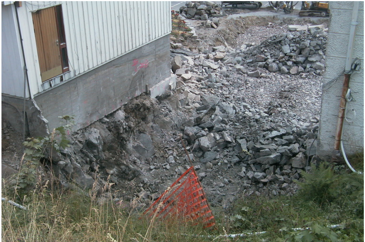
2005-08-03 Ende bibliotekbrakke og hjørne nordøst A, mot sørøst. Understøpt
