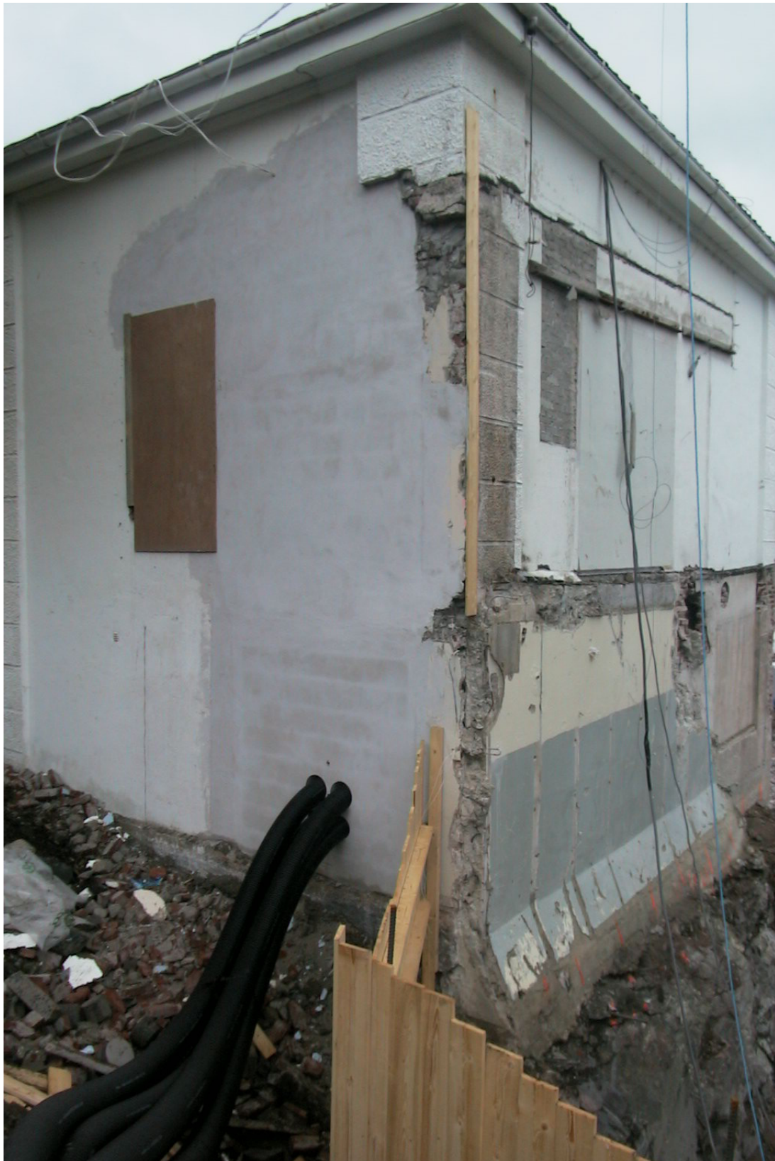
2005-08-23 Hjørne nordvest A, mot sørøst. 3. og 4. etasje.
