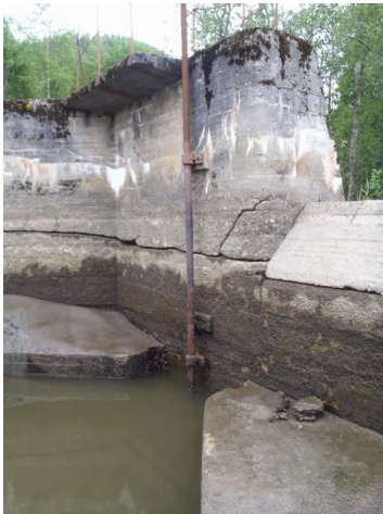
Bilde nr 11: Lukestang for søndre bunnluke. Ny betongplate på 300 mm vil bli støpt her.
