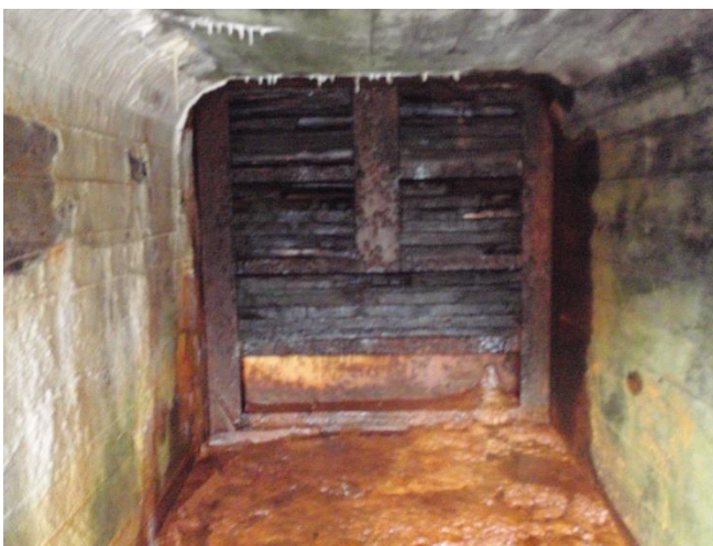
Bilde nr 12: Søndre bunnluke sett fra nedstrøms side
