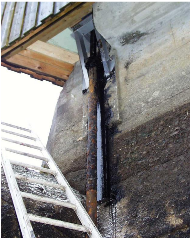
Bilde nr 4: Stålkonsoll for bæring av lukespill. Overgang spindel/lukestang (Nordre bunnluke)
