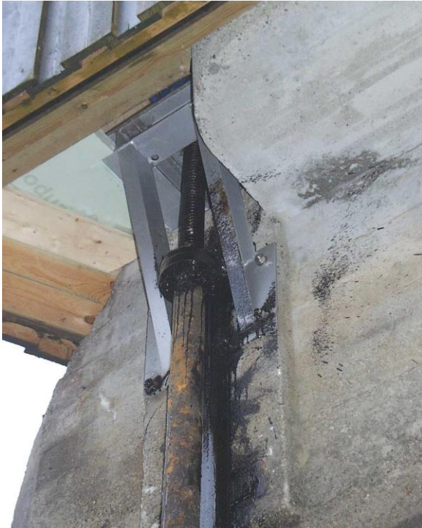
Bilde nr 3: Stålkonsoll for bæring av lukespill. Overgang spindel/lukestang (Nordre bunnluke)
