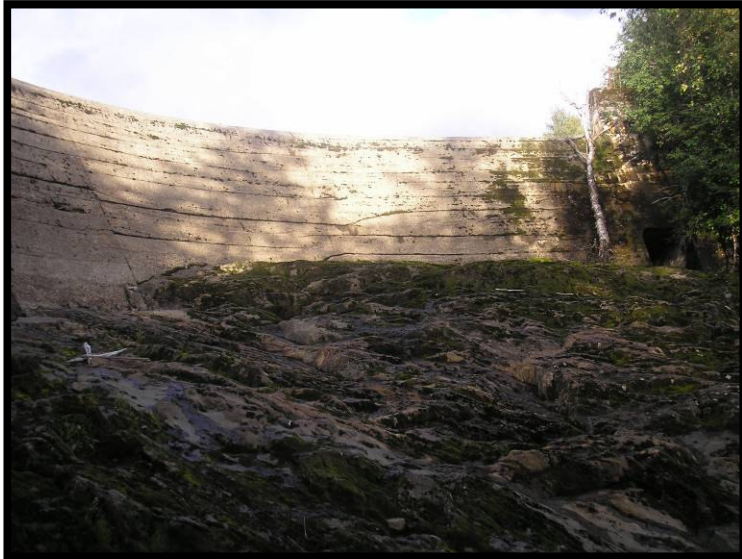
Massiv buedam sett fra nedstrøms side.
