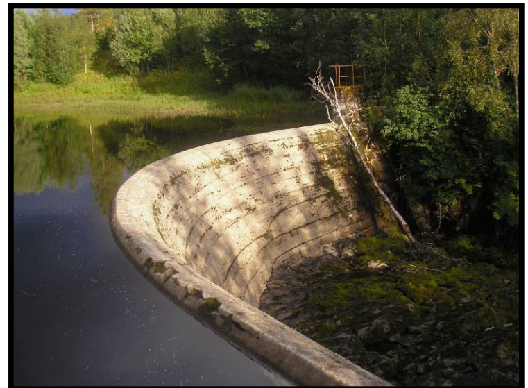
Massiv buedam sett fra nord (inntak)
