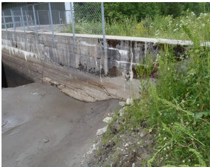
Landfeste nord med tilhørende lukehus.
