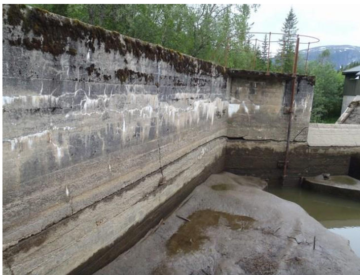
Overgang fra landfeste til overløpsdam. Ser også deler av tappeluke sør, som ikke har vært i bruk på mange år.
