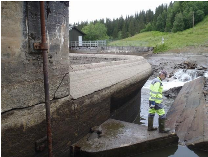
Overgang til buet overløpsdam med rester av gammel dam oppstrøms.
