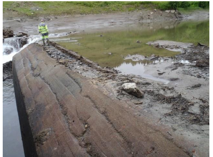
Overgang til buet overløpsdam med rester av gammel dam oppstrøms.
