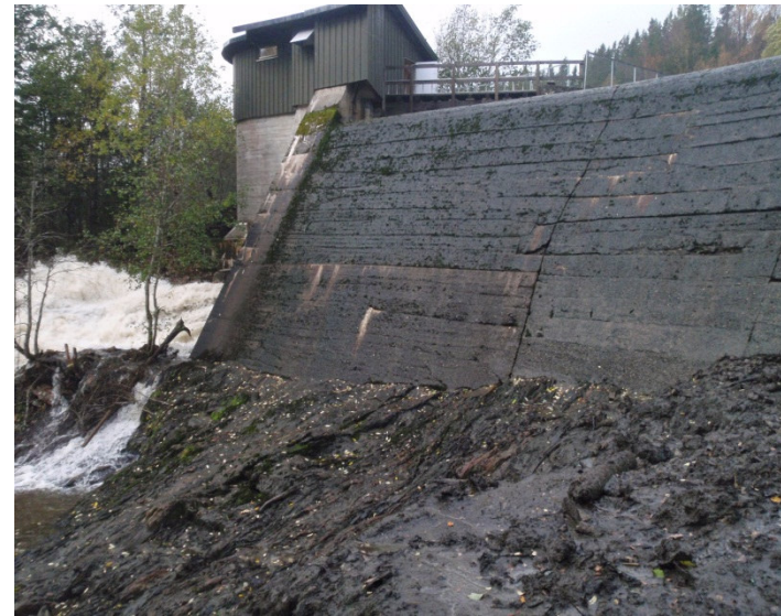
Massiv buedam og inntakshus sett fra nedstrøms side.
