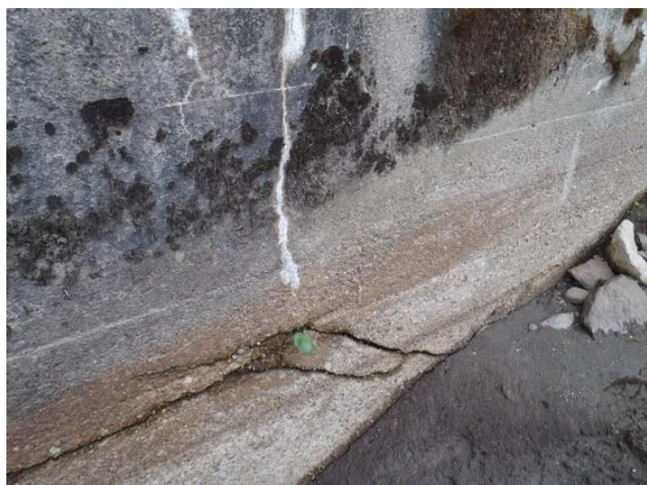
Detaljer fra landfeste nord. Viser tydelige sprekker i betongen. Delvis trolig gamle støpeskjøter
