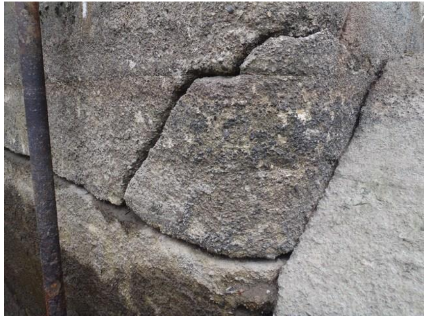
Gammel tappeluks på sørsiden: sveivesystem fungerer ikke. Detaljbilde viser tydelige skader i betongen.
