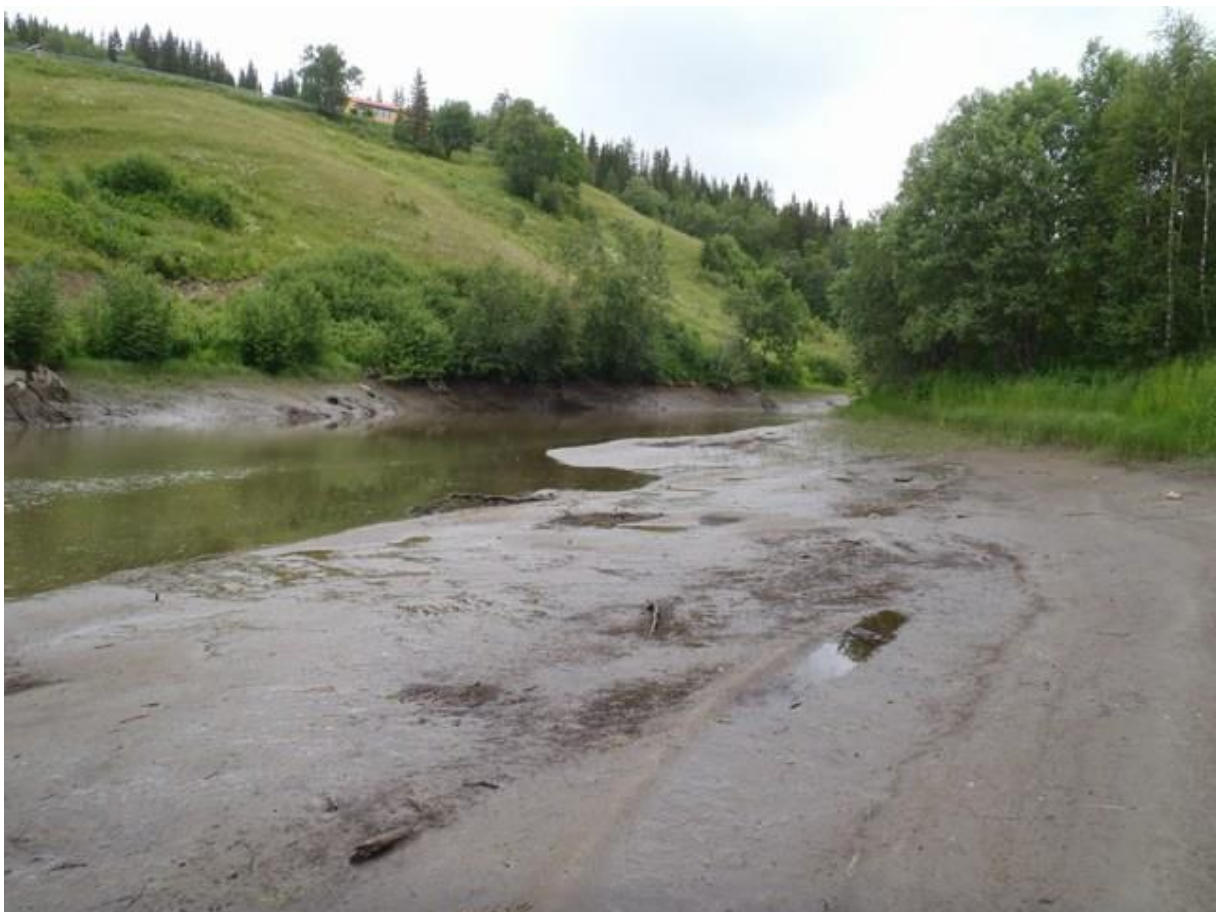
Også oppstrøms i magasinet er det mye sedimentert masse som kan mudres bort for å oppnå større magasinvolum.
