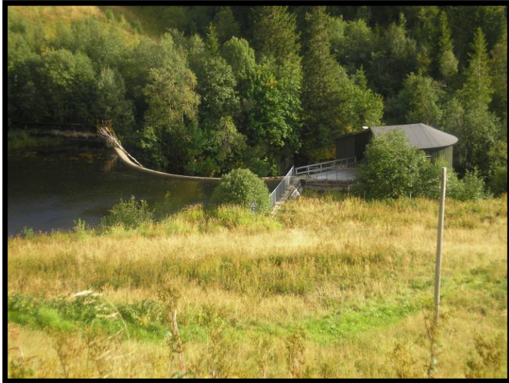
Inntaksdam Andåsfossen. Inntak til høyre.
