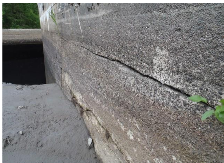
Detaljer fra landfeste nord. Viser tydelige sprekker i betongen. Delvis trolig gamle støpeskjøter
