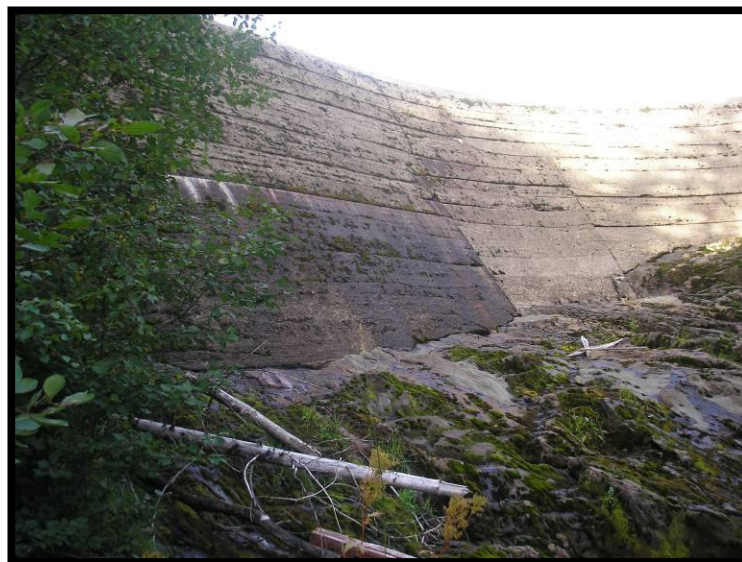
Massiv buedam sett fra nedstrøms side
