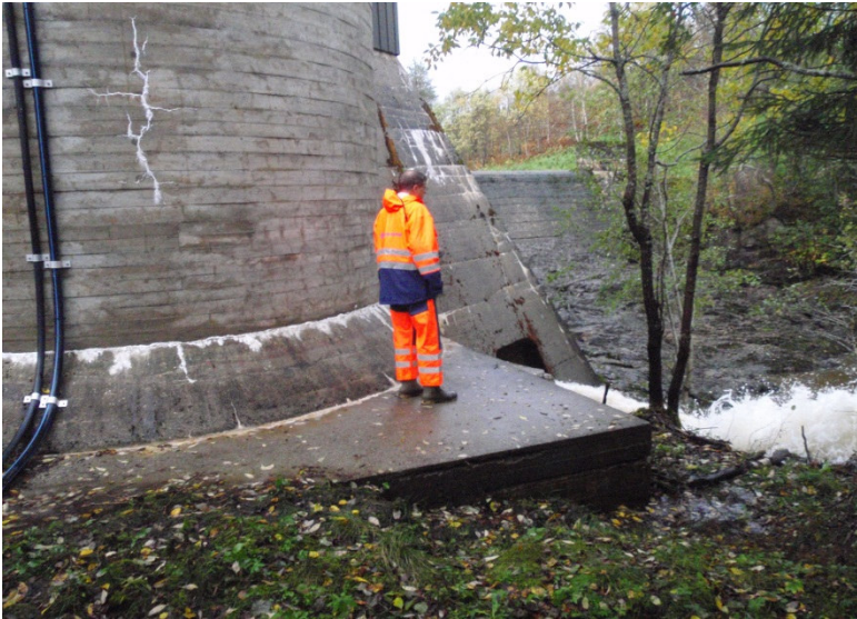
Inntakshus og norde bunntappeløp.
