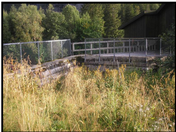
Nordre landfeste med tilhørende inntak
