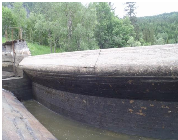
Overgang fra landfeste til overløpsdam. Ser også deler av tappeluke sør, som ikke har vært i bruk på mange år.
