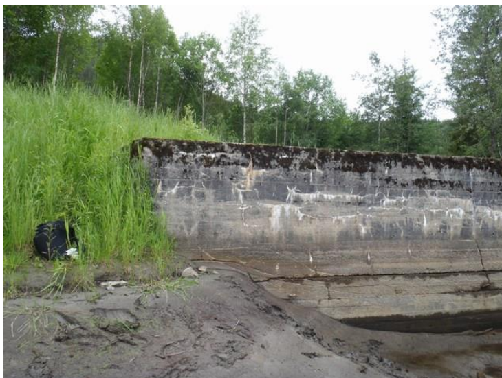
Landfeste sør: til høyre: detaljbilde som viser oppsprekking i betongen.
