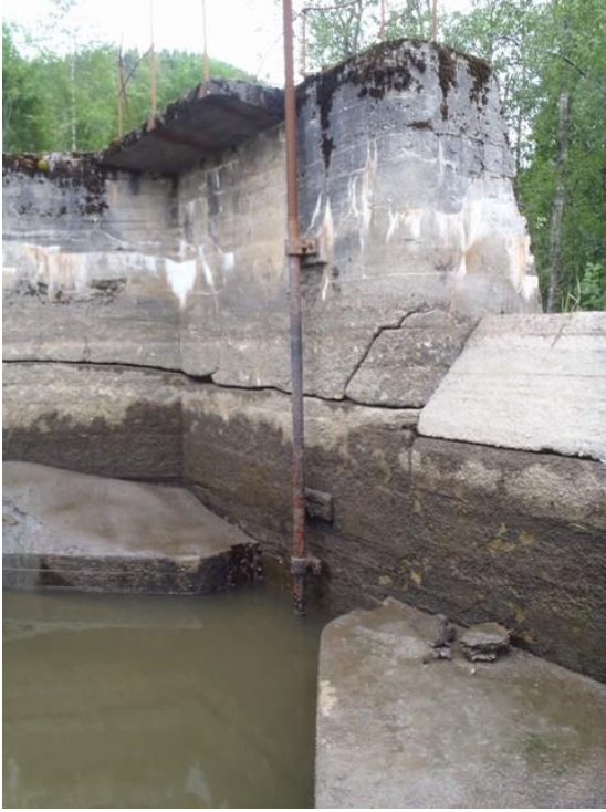
Gammel tappeluks på sørsiden: sveivesystem fungerer ikke. Detaljbilde viser tydelige skader i betongen.
