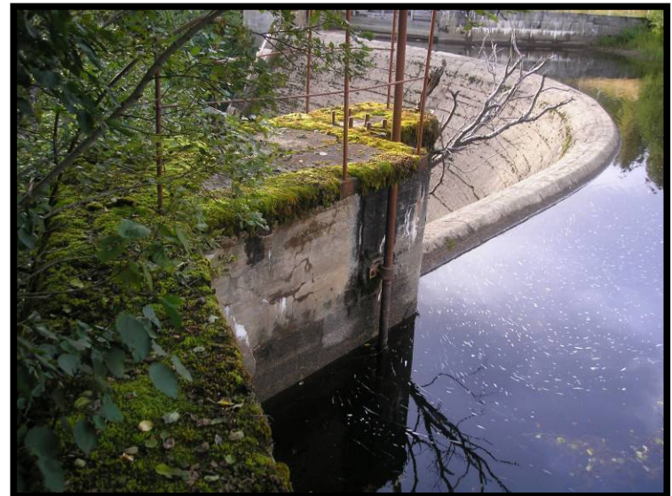
Massiv buedam med dekke sett fra landfeste sør
