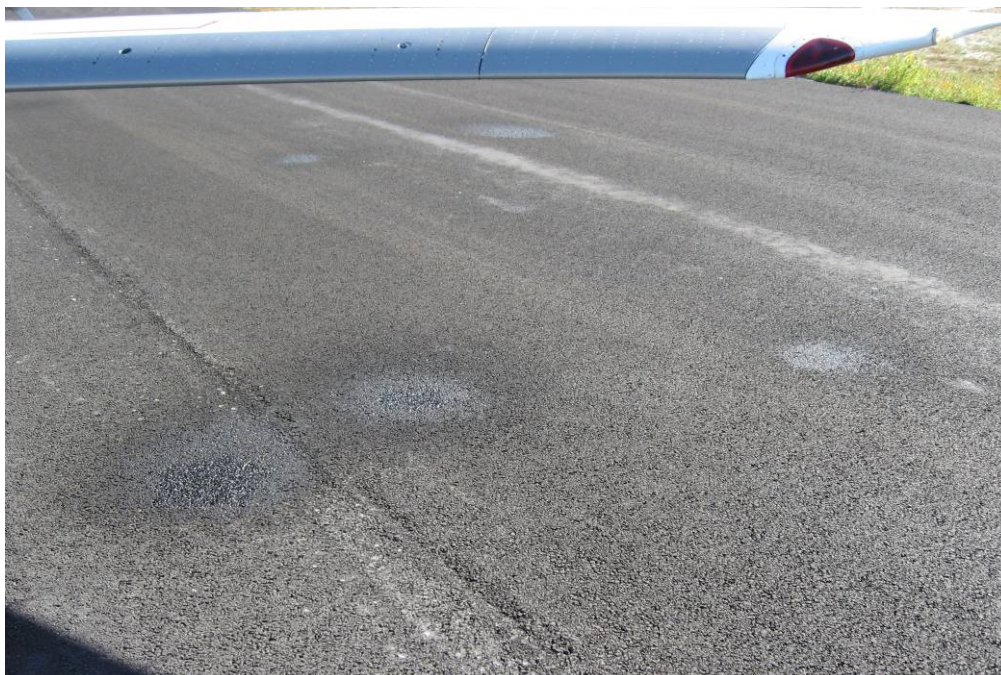
Figur 5.1 Eksempel på fuelsøl på asfalt i forbindelse med tanking.
