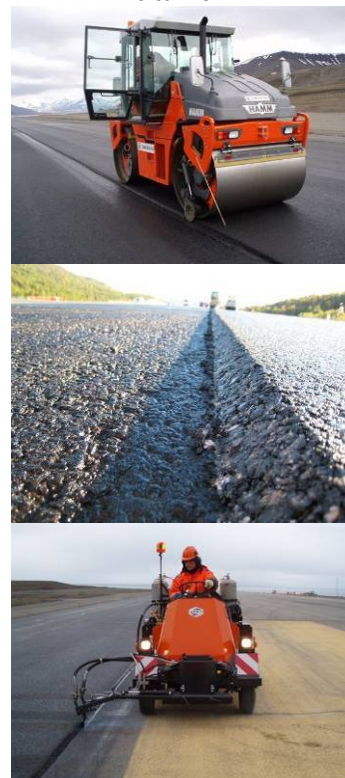
Figur 11.1 Etablering av skjøter
