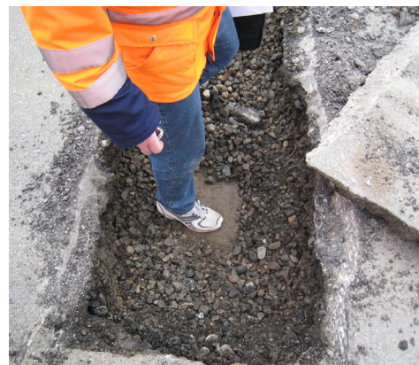
Figur 7.8 Eksempel på prøvegraving
