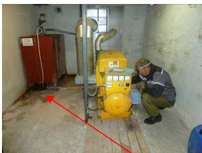
Bilde 53 viser oljetanke og aggregat i inventar 1018 i Kitdalen. Oljesøl.
