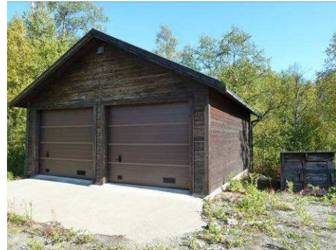
Bilde 6 viser inventar 0034, lager (garasje) og pumpehus i Skibotn. Anlegget er på 38 kvm. På skilt inne i garasjen står det at anlegget er 193955/1013.
