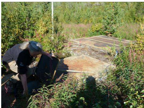
Bilde 5 viser dekningsrom i Skibotn. Inne i anlegget står det skilt om at dette anlegget er 193955/1010. Anlegget er oppført i 1986.
