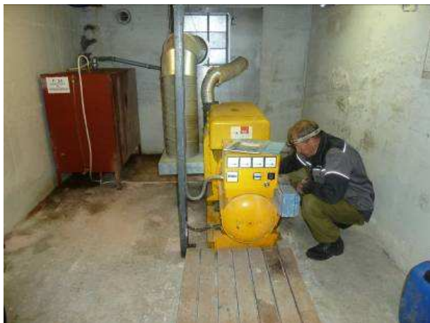
Bilde 56 viser oljetank og aggregat i inventar 1018 i Kitdalen.
