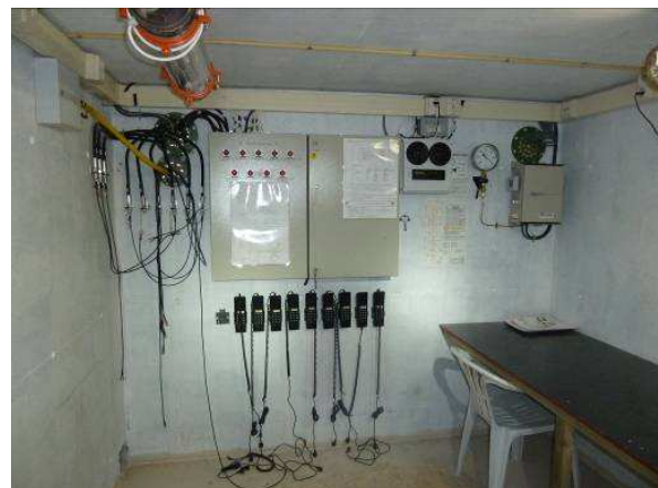
Bilde 25 viser kabelskinne i plast i inventar 1007 i Signaldalen.
