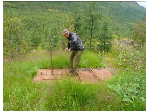
Bilde 19 viser inngang til inventar 1010 i Øvergård. Dekningsrommet er oppført i 1995 og er på ca 220 m 2 .
