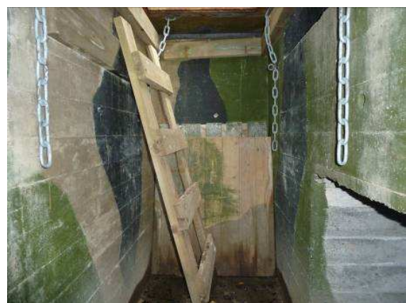
Bilde 29 viser stige av CCA-impregnert trevirke observert i inventar 1001 i Storfjord.
