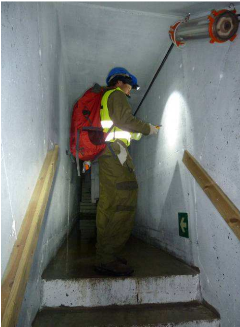
Bilde 46 viser prøvetaking av hvitmaling på vegg i inventar 1007 i Signaldalen.
