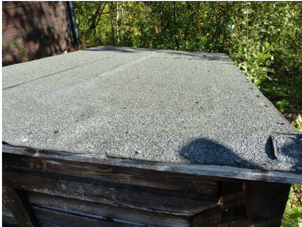
Bilde 58 viser takbelegg på pumpehus som står rett ved garasje 193955/1013.
