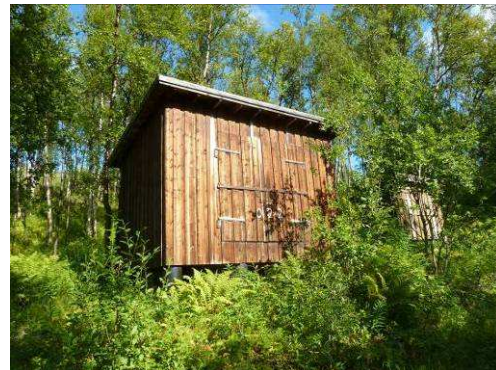
Bilde 7 viser Blokkhus for Mitr/Mg som er et stillings-/sperreanlegg på 9 kvm. Anlegget omfatter tre små trebygninger
