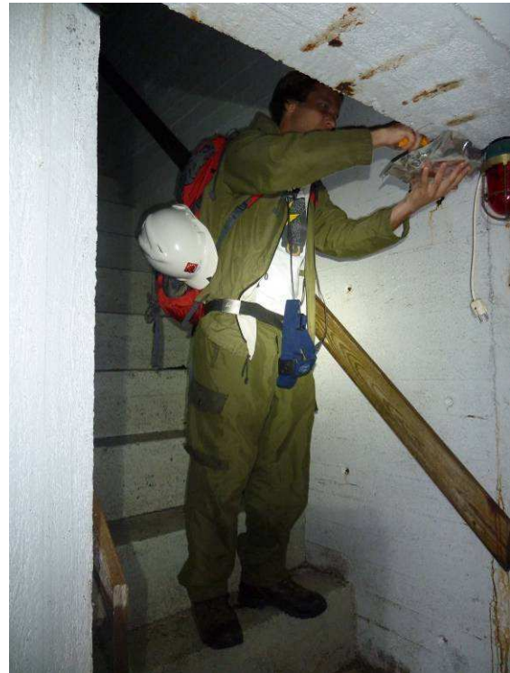
Bilde 51 viser prøvetaking av hvitmaling fra tak og vegger i inventar 1009 Kitdalen.
