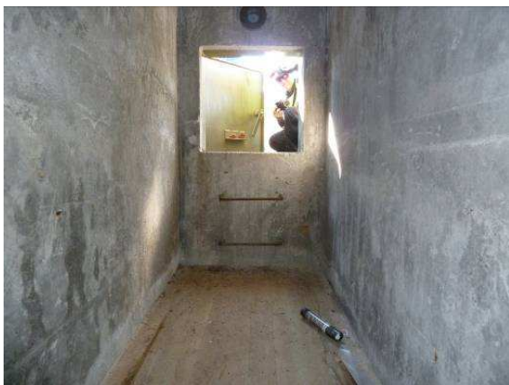
Bilde 27 viser CCA-impregnert trevirke som gulv i en mitr.-stilling E-1 i Kitdalen.
