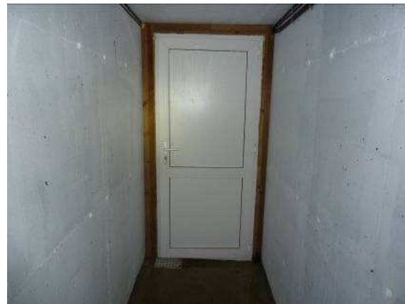
Bilde 28 viser CCA-impregnert trevirke rundt dørkarmen i inventar 1006 på Oteren.
