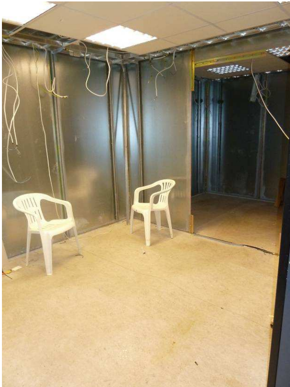
Bilde 34 viser gulvbelegg som skal håndteres som farlig avfall i inventar 1007 i Signaldalen.
