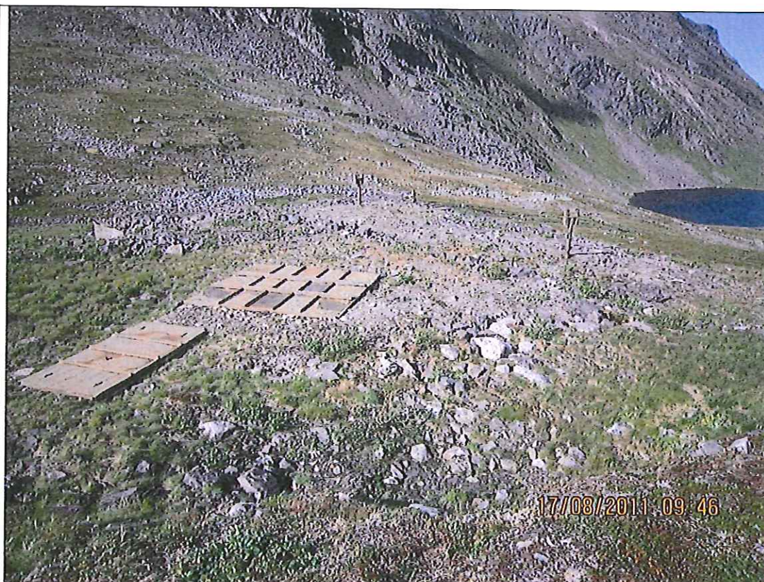
Viser stilling/nedgang til anlegget. Under lufterør ligger dekningsrom
