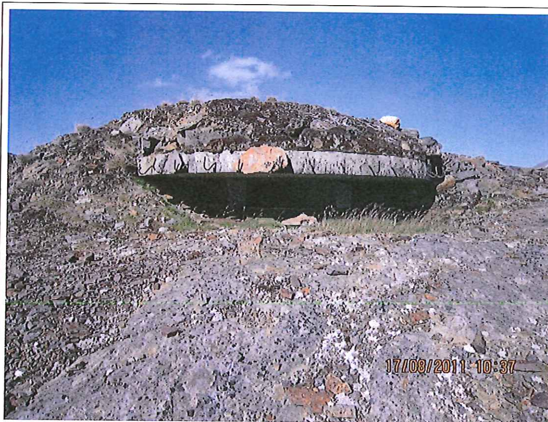
Mitraljøsestilling E-1 med dekningsrom. Areal 10m 2 . Bilde tatt mot skyteåpning
