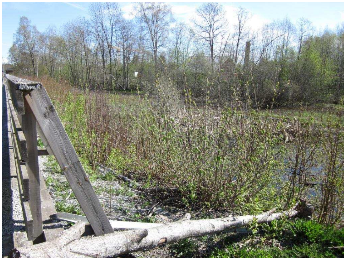
Området på andre siden av sporene viser at grunnvannet står høyt
