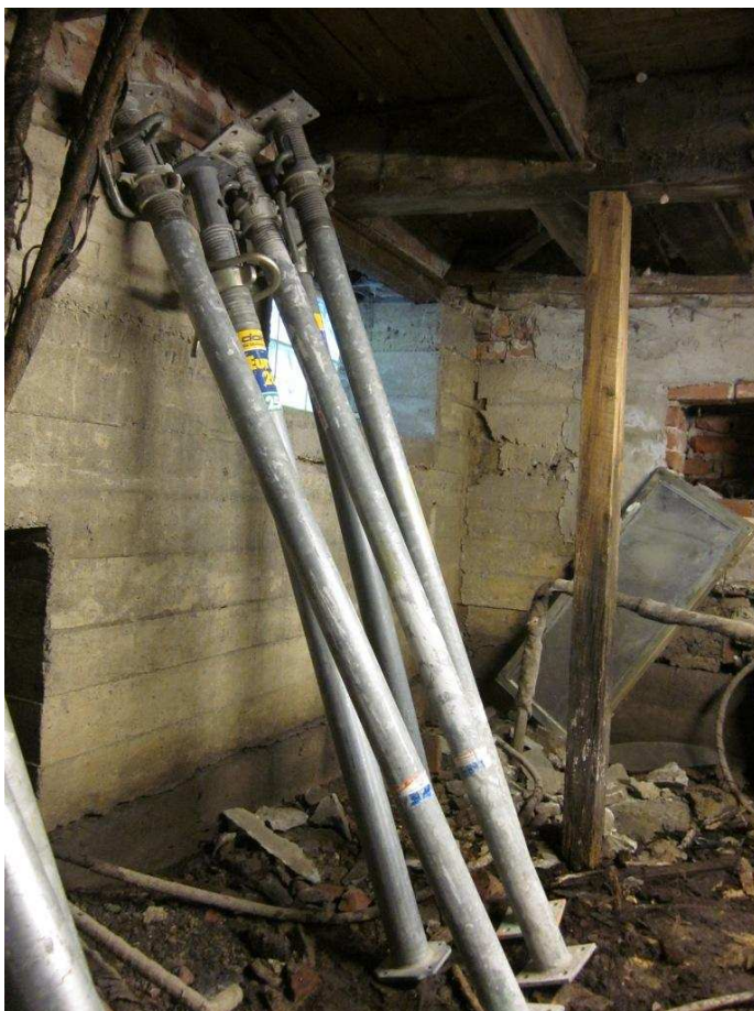
Stemplingsbein brukes som midlertidig oppstøttelse av bjelkelag
