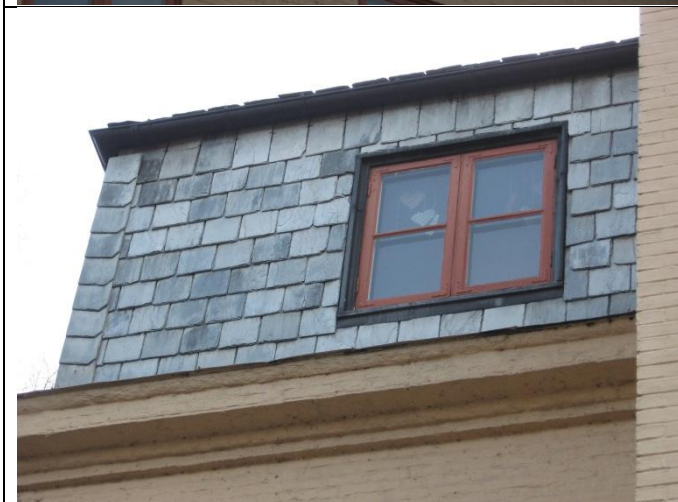
Utvendig hjørne (overgang bygningsdel øst og sør) på vestsiden av bygget;
