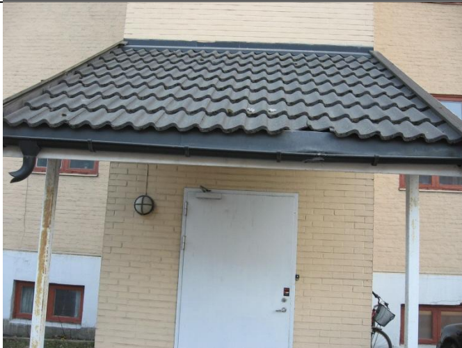
Bygningsdel «sør» - vestside Tak over inngang til heis.
