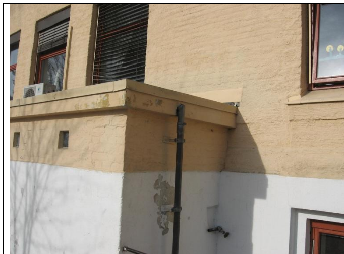
Lavt tak over lager/teknisk rom.
