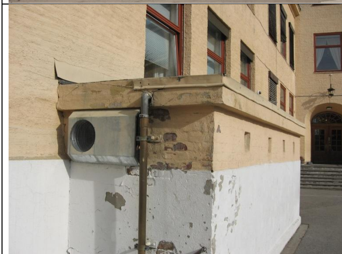
Lavt tak over trapp til kjeller
