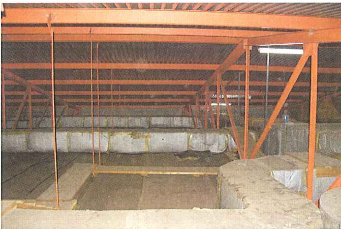
Bilde av takkonstruksjonen i loftet.
