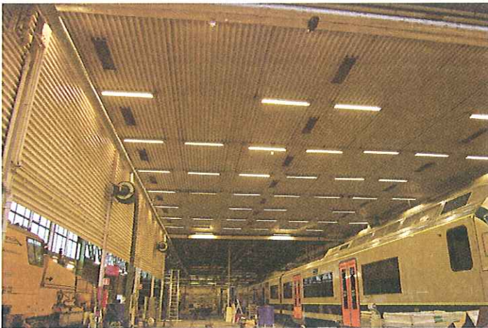
Bilde av takkonstruksjonen i verkstedhallen.
