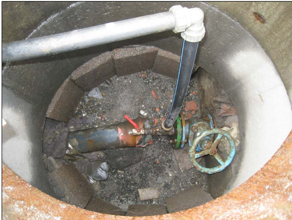
Bilde av eksisterende vannkum V20
