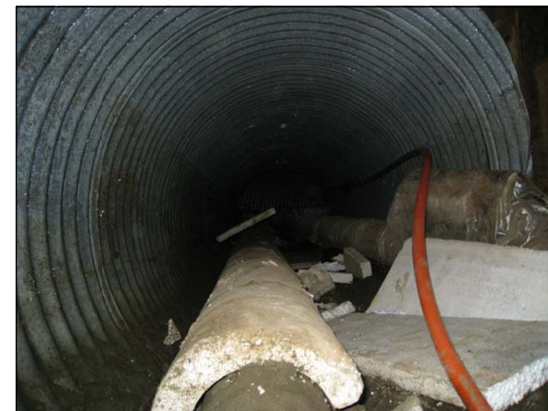
Bilde av kulvert med eksisterende VA-ledninger. Fiberkabelen er lagt om og fjernet av Eidefoss
