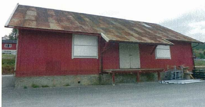
Side mot P - plass / Male vinduer / dør / vegg
