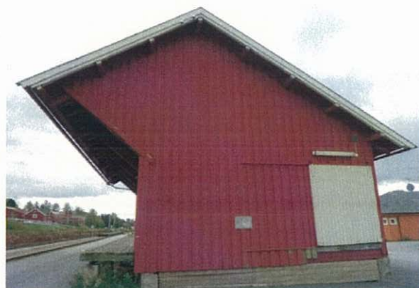
Side mot Nord Male dør / vindskier / vegg
