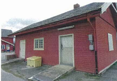
Side mot spor Montering av takrenner Maling dør og vinduer
