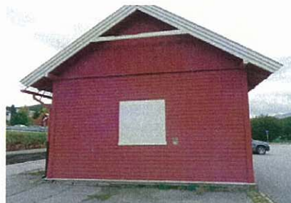
Side mot Godshus Ønske om innsetting av nytt vindu Maling dør / vindskier
