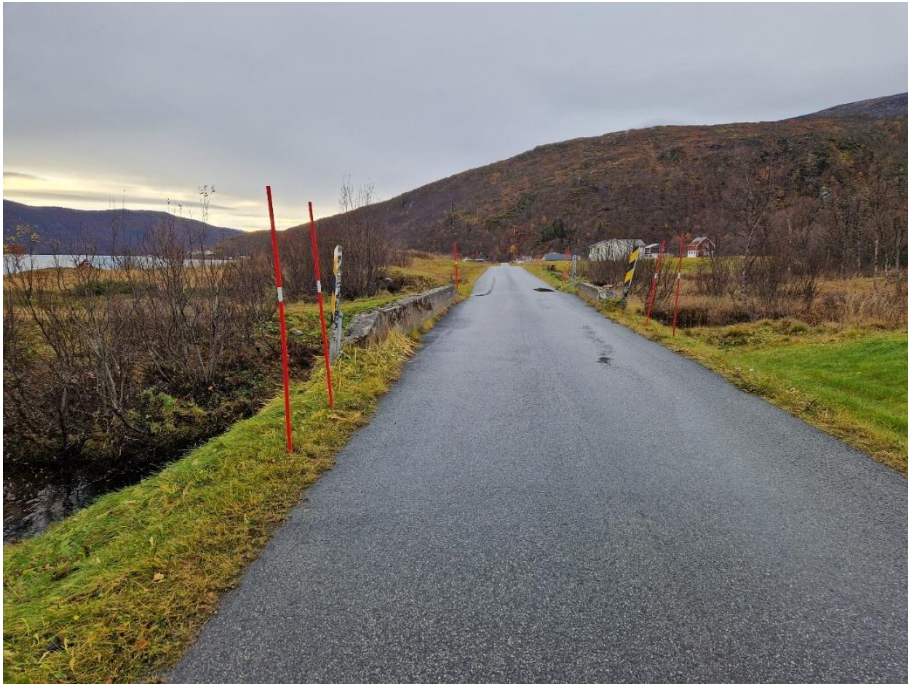
Figur 4-2: Bilde tatt fra sørsiden av brua
