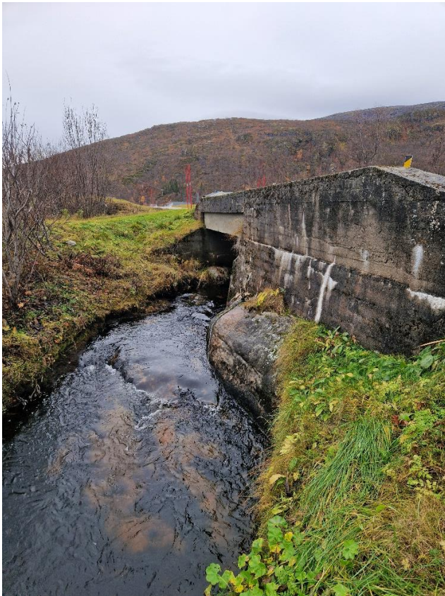
Figur 4-1: Venstre: Nedstrøms brua. Brufundamentet er støpt på massivt berg (granitt). Høyre: Oppstrøms brua. I elveleiet er det et tynt lag av sand og grus over berg
