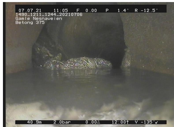
10, 00:05:16, 40.90m Dimensjonsendring til, S 375 mm / overgravd kum og dimensjonsendring
