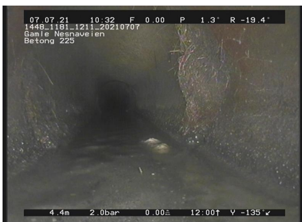
3, 00:01:30, 4.40m Røtter, reduksjon av tverrsnittsarealet er mellom 5 - 15%, av 1 Kl. til 5 Kl., Sammenfildrede røtter / rottugge
