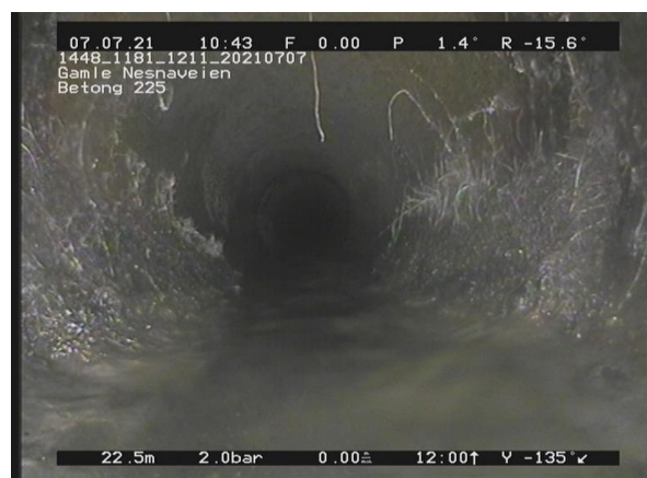
16, 00:06:18, 22.59m Røtter, reduksjon av tverrsnittsarealet er mellom 5 - 15%, av 4 Kl. til 8 Kl., Sammenfildrede røtter / rottugge
