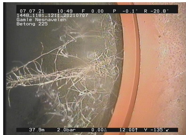
22, 00:08:50, 37.99m Røtter, reduksjon i tverrsnittsarealet er 5% eller mindre, av 1 Kl. til 3 Kl., Enkelte fine rottråder
