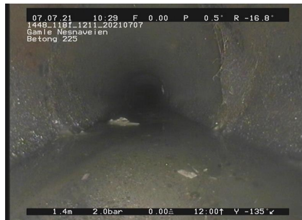
2, 00:00:33, 1.40m Røtter, reduksjon i tverrsnittsarealet er 5% eller mindre, av 1 Kl. til 5 Kl., Sammenfildrede røtter / rottugge
