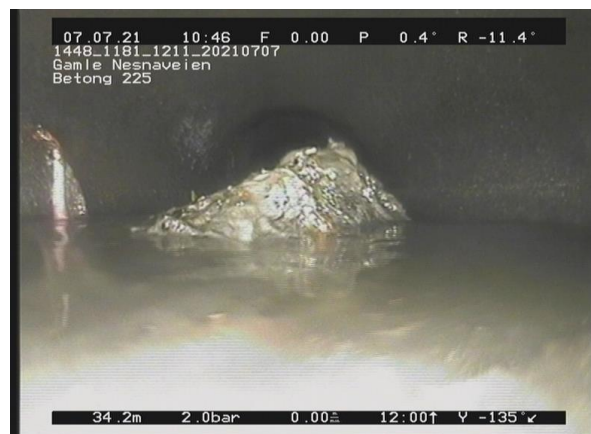
18, 00:07:58, 34.29m Sedimentering, dybde på avsetning er mellom 5-15%, av 5 Kl. til 7 Kl., Sanitaeravfall
