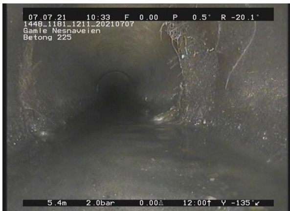
5, 00:01:50, 5.42m Røtter, reduksjon av tverrsnittsarealet er mellom 5 - 15%, av 1 Kl. til 5 Kl., Sammenfildrede røtter / rottugge
