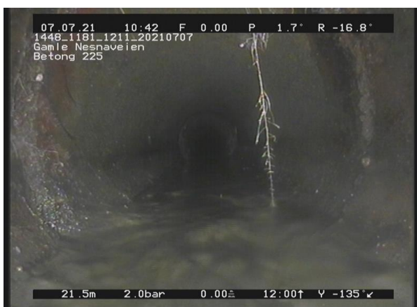
15, 00:06:02, 21.56m Røtter, reduksjon i tverrsnittsarealet er 5% eller mindre, på 12 Kl., Enkelte fine rottråder
