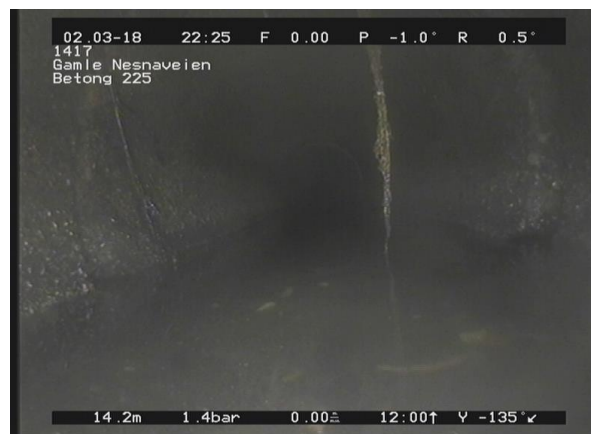
10, 00:03:06, 14.22m Røtter, reduksjon i tverrsnittsarealet er 5% eller mindre, på 12 Kl., Enkelte fine rottråder
