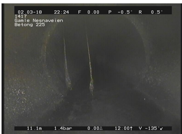
7, 00:02:29, 11.11m Røtter, reduksjon i tverrsnittsarealet er 5% eller mindre, på 11 Kl., Enkelte fine rottråder
