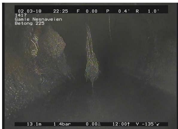
9, 00:02:55, 13.19m Røtter, reduksjon av tverrsnittsarealet er mellom 5 - 15%, av 7 Kl. til 11 Kl., Sammenfildrede røtter / rottugge
