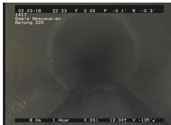
6, 00:02:05, 8.08m Forsk. skjøt forskyvningen er mellom halve og hele rørtykkelsen, av 9 Kl. til 3 Kl., Tverrforskjøvet
