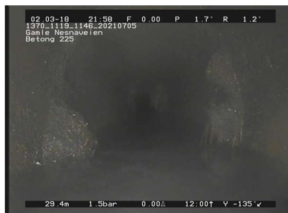
12, 00:05:58, 29.43m Røtter, reduksjon av tverrsnittsarealet er mellom 5 - 15%, av 3 Kl. til 9 Kl., Sammenfildrede røtter / rottugge
