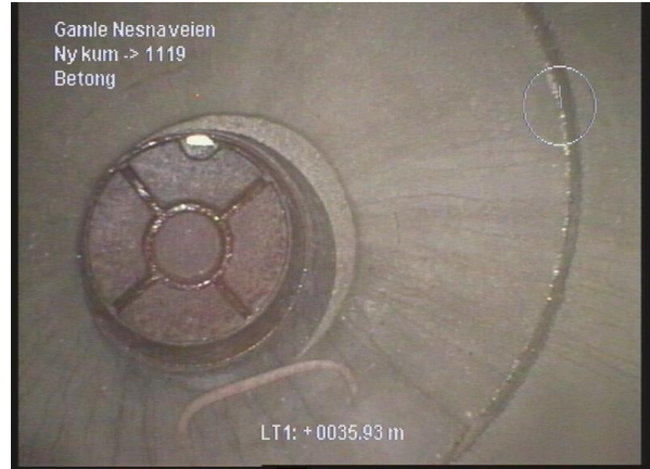
13.11.2024 135958_Ny kum_1119_13112024_020023_036.jpg, 00:00:47, 35.90m Inspeksjon fullført
