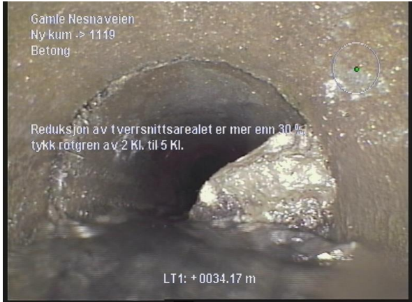
13.11.2024 135958_Ny kum_1119_13112024_020023_035.jpg, 00:00:00, 34.17m Reduksjon av tverrsnittsarealet er mer enn 30 %, tykk rotgren av 2 Kl. til 5 Kl.
