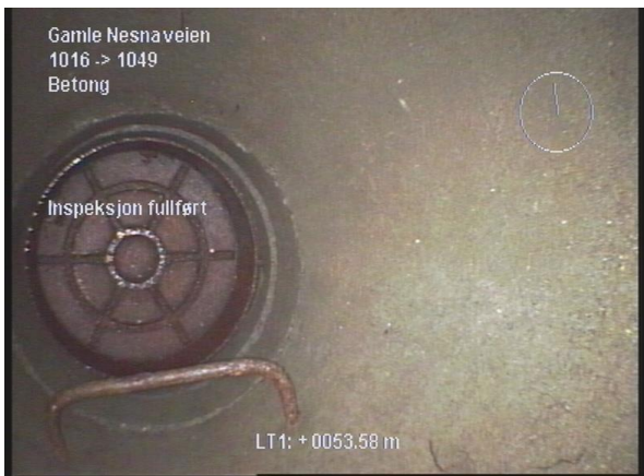
14.11.2024 150201_1016_1049_14112024_030307_054.jpg, 00:07:07, 53.50m Inspeksjon fullført
