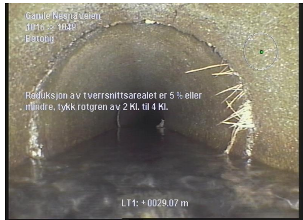
14.11.2024 150201_1016_1049_14112024_030307_045.jpg, 00:03:12, 29.00m Reduksjon av tverrsnittsarealet er 5 % eller mindre, tykk rotgren av 2 Kl. til 4 Kl.
