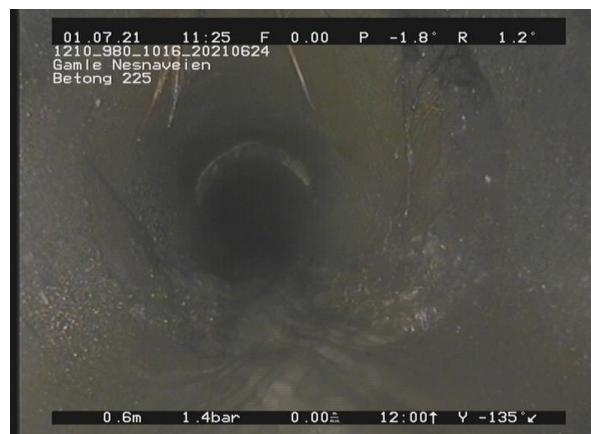
2, 00:00:17, 0.68m Røtter, reduksjon i tverrsnittsarealet er 5% eller mindre, av 11 Kl. til 4 Kl., Enkelte fine rottråder
