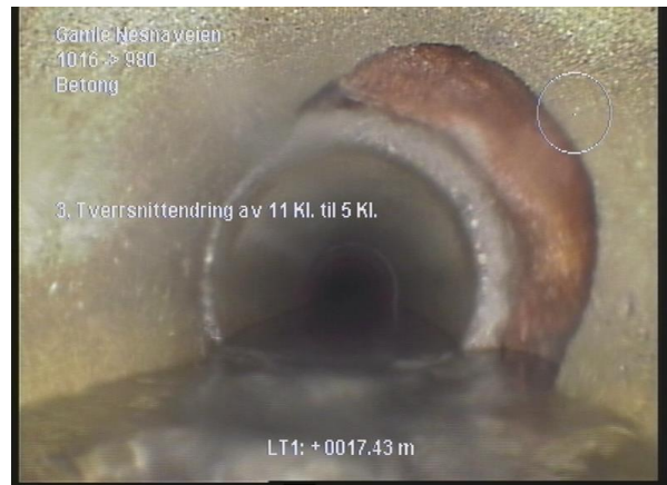
14.11.2024 152856_980_1016_14112024_032933_056.jpg, 00:02:16, 17.40m 3, Tverrsnittdring av 11 Kl. til 5 Kl.
