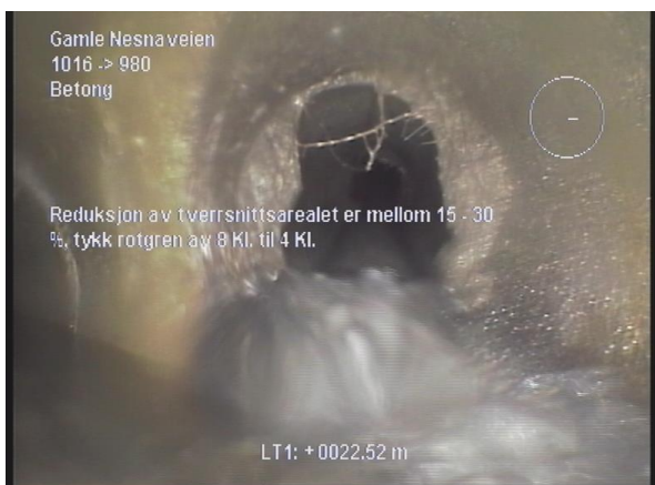
14.11.2024 152856_980_1016_14112024_032933_061.jpg, 00:04:11, 22.50m Reduksjon av tverrsnittsarealet er mellom 15 - 30 %, tykk rotgren av 8 Kl. til 4 Kl. / røtter i gren rør
