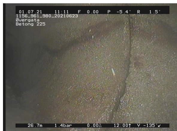
4, 00:04:09, 26.75m Røtter, reduksjon i tverrsnittsarealet er 5% eller mindre, av 4 Kl. til 5 Kl., Enkelte fine rottråder
