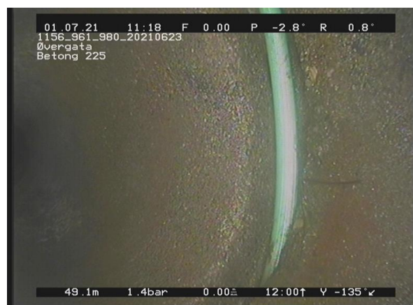
8, 00:08:03, 49.15m Synlig pakning,, Pakningsringen kan antydes i rørskjøt, av 10 Kl. til 3 Kl.
