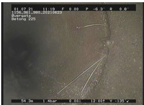
9, 00:08:48, 54.30m Røtter, reduksjon i tverrsnittsarealet er 5% eller mindre, av 2 Kl. til 5 Kl., Enkelte fine rottråder
