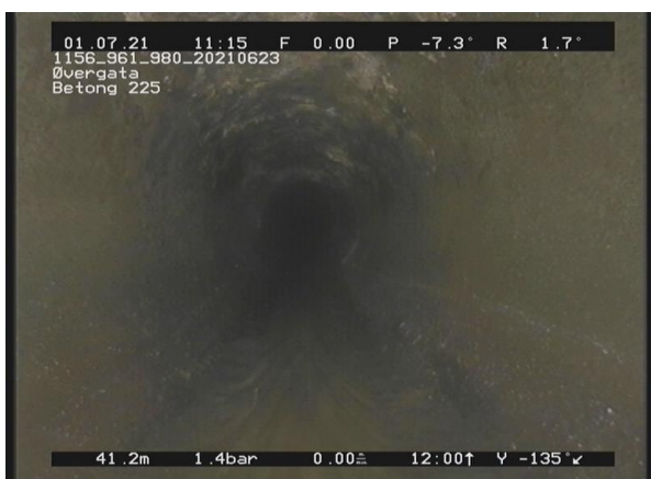
7, 00:06:52, 41.29m Utfelling/Belegg, reduksjon i tverrsnittsarealet er 5% eller mindre, av 10 Kl. til 2 Kl., Biofilm
