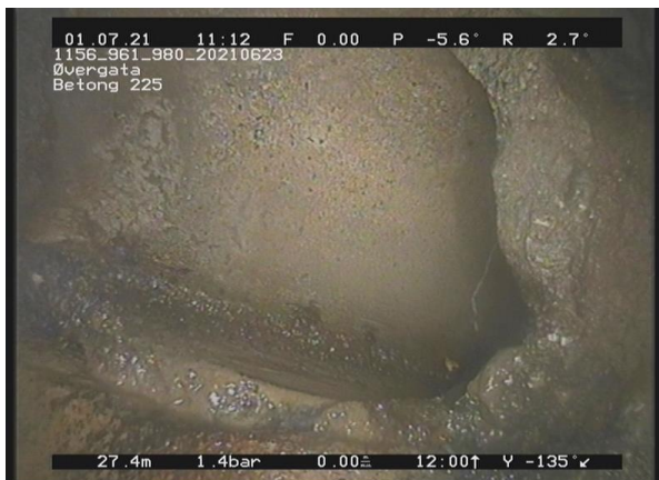
5, 00:04:37, 27.40m Tilkopling, Innhugget tilkopling av 1 Kl. til 3 Kl.
