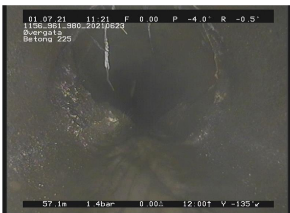
11, 00:09:27, 57.15m Røtter, reduksjon i tverrsnittsarealet er 5% eller mindre, av 9 Kl. til 1 Kl., Enkelte fine rottråder
