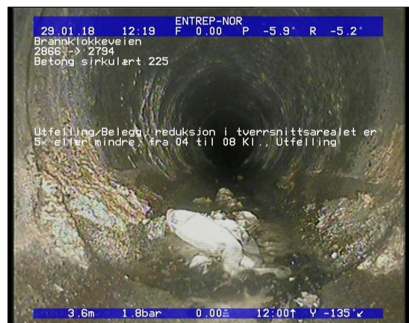
Foto: Utfelling/Belegg, reduksjon i tverrsnittsarealet er 5 eller mindre, fra 04 til 08 Kl., Utfelli.JPG 3,65m, Utfelling/Belegg, reduksjon i tverrsnittsarealet er 5% eller mindre, fra 04 til 08 Kl., Utfelling
