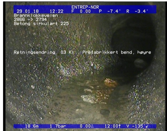
Foto: Retningsendring 03 Kl., Prefabrikkert bend, høyre_11270818,63_RE.JPG 18,63m, Retningsendring 03 Kl., Prefabrikkert bend, høyre
