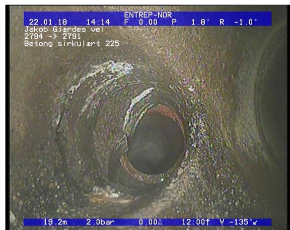
Foto: Tilknytning Prefabrikkert grennrør. fra 09 til 11 Kl., Ikke avmerket i tegning_22012018_19,09_TK.JPG 19,09m, Tilknytning Prefabrikkert grennrør. fra 09 til 11 Kl., Ikke avmerket i tegning
