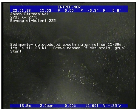
Foto: Sedimentering,dybde på avsetning er mellom 15-30, fra 04 til 08 Kl., Grove masser (f eks stein.JPG 47,95m, Sedimentering,dybde på avsetning er mellom 15-30%, fra 04 til 08 Kl., Grove masser (f eks stein, grus), Start
