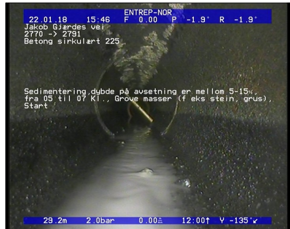
Foto: Sedimentering,dybde på avsetning er mellom 5-15%, fra 05 til 07 Kl., Grove masser (f eks stein, grus), Start 29,25m, Sedimentering,dybde på avsetning er mellom 5-15%, fra 05 til 07 Kl., Grove masser (f eks stein, grus), Start
