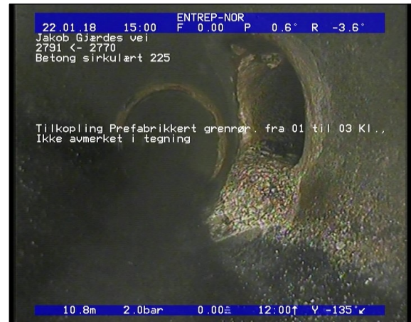
Foto: Tilkopling Prefabrikkert grenrør. fra 01 til 03 Kl., Ikke avmerket i tegning_22012018_10,88_TK.JPG 53,98m, Tilkopling Prefabrikkert grenrør. fra 09 til 11 Kl., Ikke avmerket i tegning
