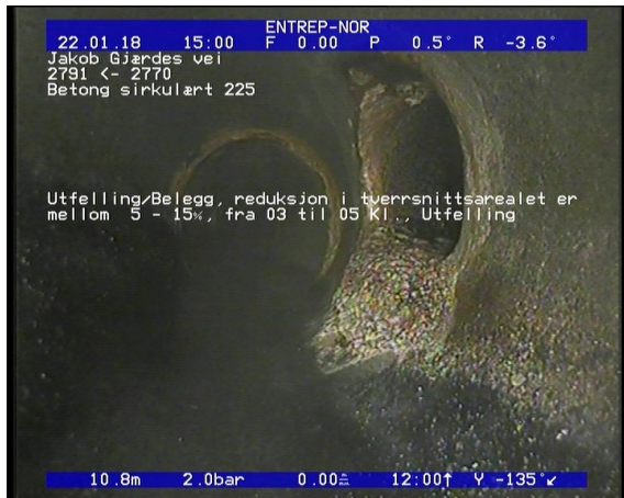
Foto: Utfelling/Belegg, reduksjon i tverrsnittsarealet er mellom 5 - 15, fra 03 til 05 Kl., Utfelli.JPG 53,98m, Utfelling/Belegg, reduksjon i tverrsnittsarealet er mellom 5 - 15%, fra 07 til 09 Kl., Utfelling
