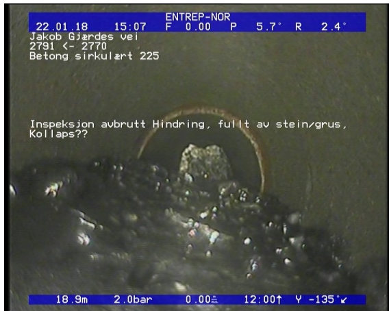
Foto: Inspeksjon avbrutt Hindring, fullt av steingrus, Kollaps_22012018_18,91_IA.JPG 45,95m, Inspeksjon avbrutt Hindring, fullt av stein/grus, Kollaps??
