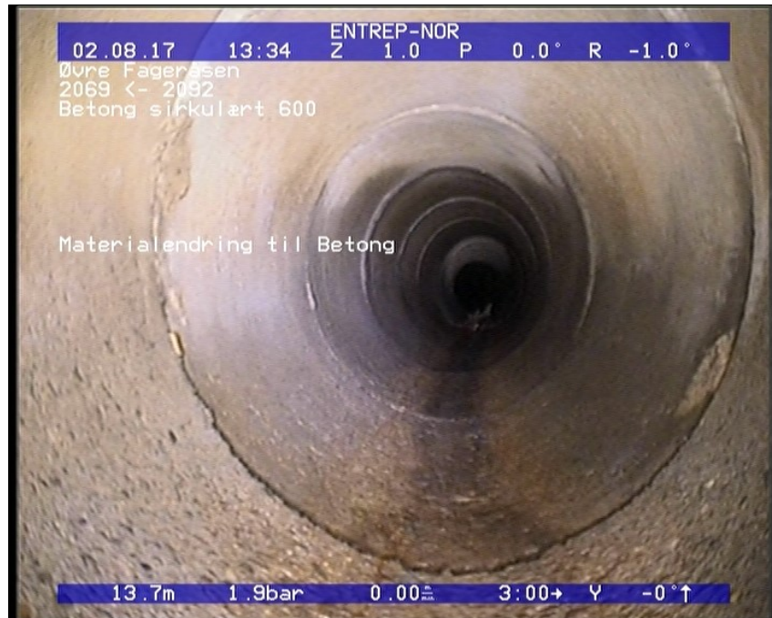
Foto: 49_49_946_A.JPG 13,78m, Materialendring til Betong
