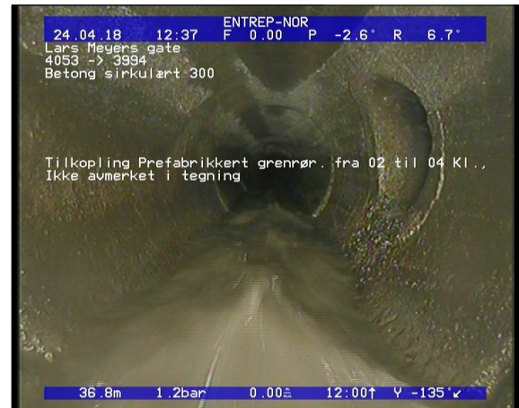
Foto: Tilkopling Prefabrikkert grenrør. fra 02 til 04 Kl., Ikke avmerket i tegning_12414236,88_TK.JPG 36,88m, Tilkopling Prefabrikkert grenrør. fra 02 til 04 Kl., Ikke avmerket i tegning
