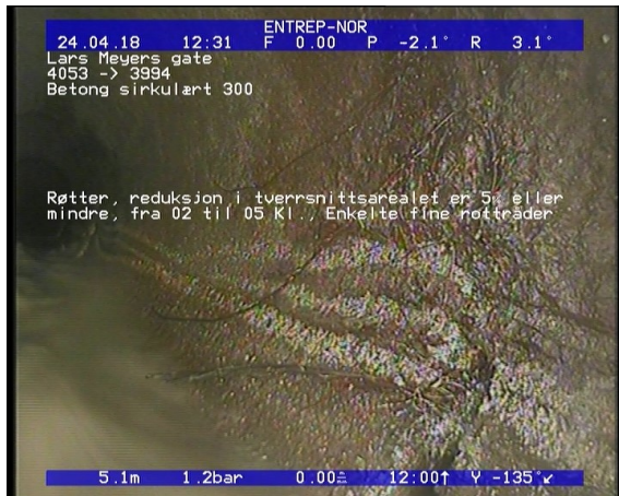
Foto: Røtter, reduksjon i tverrsnittsarealet er 5 eller mindre, fra 02 til 05 Kl., Enkelte fine rottråder.JPG 5,12m, Røtter, reduksjon i tverrsnittsarealet er 5% eller mindre, fra 02 til 05 Kl., Enkelte fine rottråder
