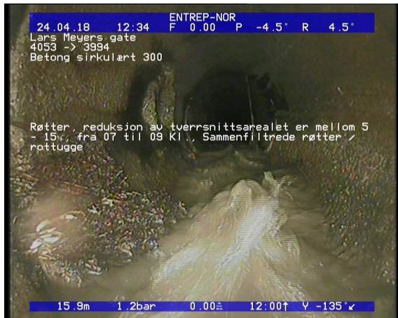
Foto: Røtter, reduksjon av tverrsnittsarealet er mellom 5 - 15, fra 07 til 09 Kl., Sammenfiltrede rø.JPG 15,93m, Røtter, reduksjon av tverrsnittsarealet er mellom 5 - 15%, fra 07 til 09 Kl., Sammenfiltrede røtter / rottugge
