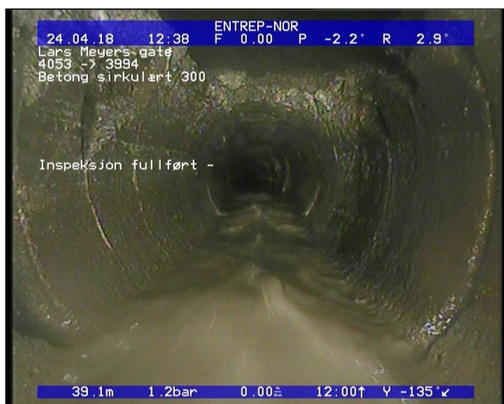
Foto: Inspeksjon fullført -_12420639,14_IF.JPG 39,14m, Inspeksjon fullført -
