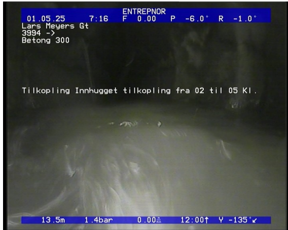
Foto: 4_1_Nr (SO_Counter)_28022019_095618.JPG 13,51m, Tilkopling Innhugget tilkopling fra 02 til 05 Kl.
