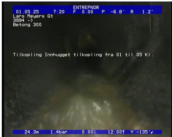
Foto: 4_1_Nr (SO_Counter)_28022019_100013.JPG 24,36m, Tilkopling Innhugget tilkopling fra 01 til 05 Kl.
