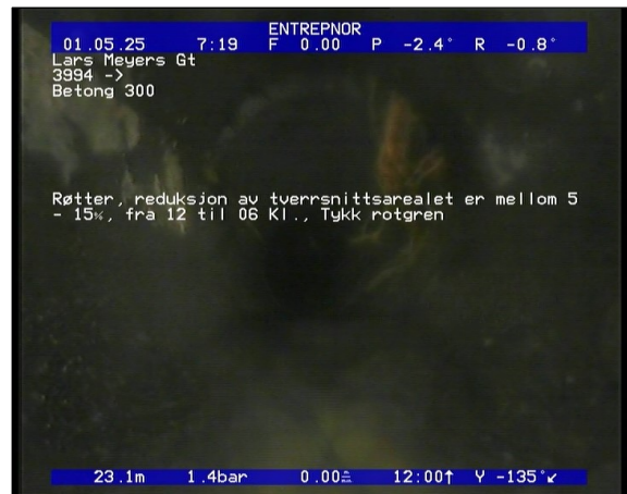
Foto: 4_1_Nr (SO_Counter)_28022019_095926.JPG 23,14m, Røtter, reduksjon av tverrsnittsarealet er mellom 5 - 15%, fra 12 til 06 Kl., Tykk rotgren
