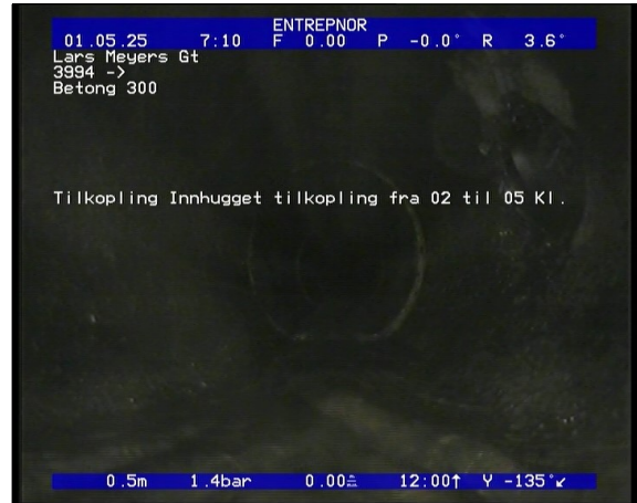
Foto: 4_1_Nr (SO_Counter)_28022019_095050.JPG 0,57m, Tilkopling Innhugget tilkopling fra 02 til 05 Kl.
