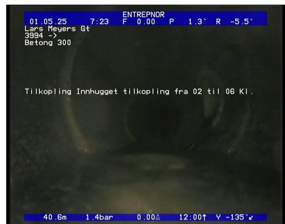
Foto: 4_1_Nr (SO_Counter)_28022019_100346.JPG 40,6m, Tilkopling Innhugget tilkopling fra 02 til 06 Kl.
