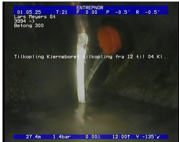
Foto: 4_1_Nr (SO_Counter)_28022019_100132.JPG 27,48m, Tilkopling Kjerneboret tilkopling fra 12 til 04 Kl.
