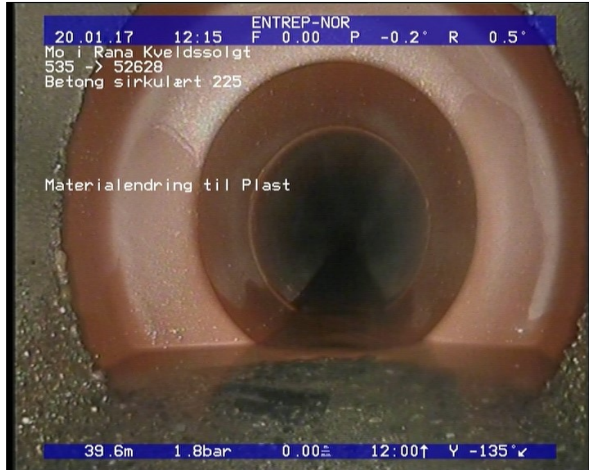
Foto: 2_2_57_A.JPG 39,61m, Materialending til Plast
