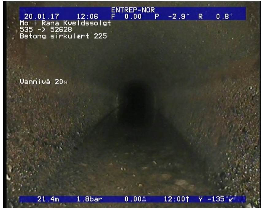
Foto: 2_2_34_A.JPG 21,43m, Vannivå 20%
