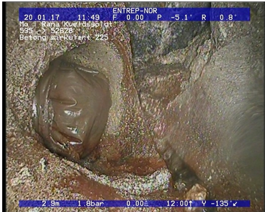
Foto: 2_2_14_B.JPG 2,83m, Tilkopling Innhugget tilkopling fra 07 til 11 Kl.
