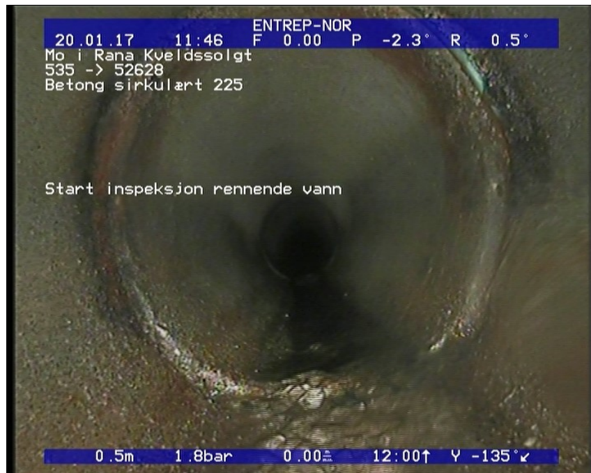
Foto: 2_2_9_A.JPG 0,5m, Start inspeksjon rennende vann
