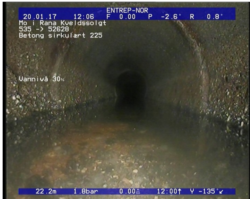
Foto: 2_2_35_A.JPG 22,29m, Vannivå 30%
