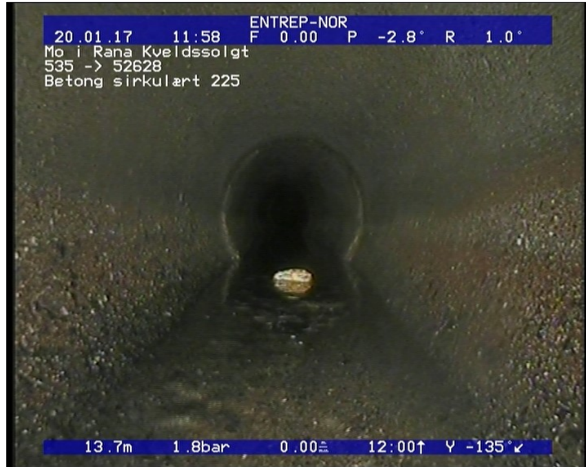
Foto: 2_2_27_A.JPG 13,75m, Vannivå 20%
