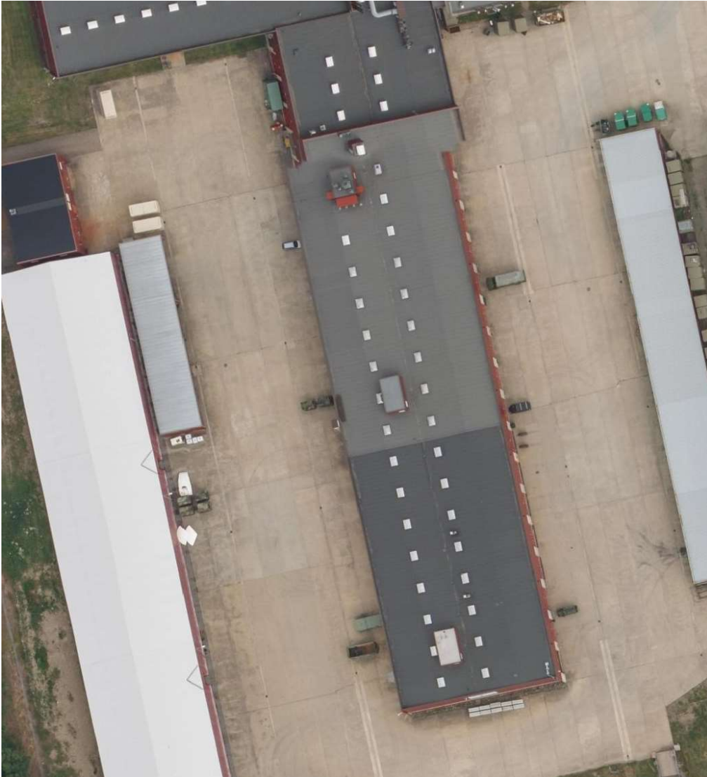
Dagens tekniske rom/ventilasjonsaggregater på tak, plassert mellom akse L og I
