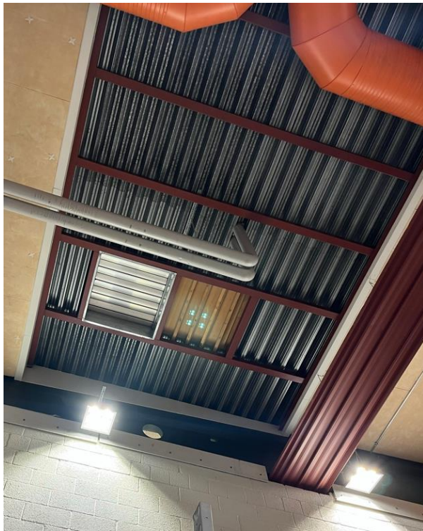
Område av himling i verkstedhall som skal isoleres.
