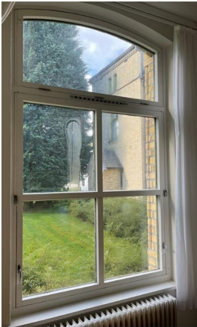
Innvendig – vindu som skal fjernes;
