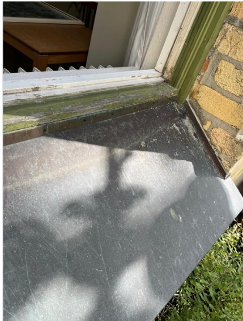
Detalj utvendig – vindu som skal fjernes.
