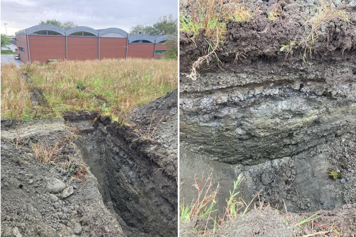
Figur 3 Gravesjakt i prøvepunkt P1. Matjord i øvre sjikt etterfulgt av eldre fyllmasser og siltig sand. Vanninnsig i sjakt.
