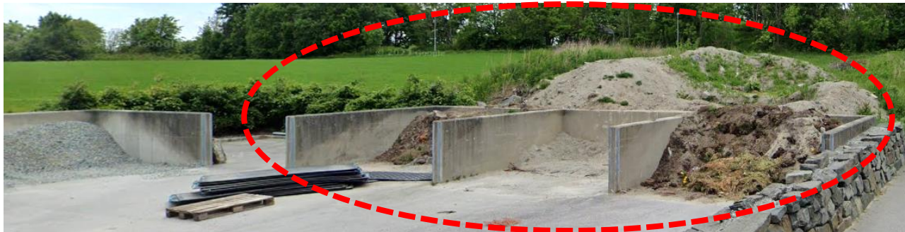
Figur 2: Eksisterende konstruksjon i betong som må fjernes, enten ved riving eller flytting, i forbindelse med utvidelsen av gravlunden.
