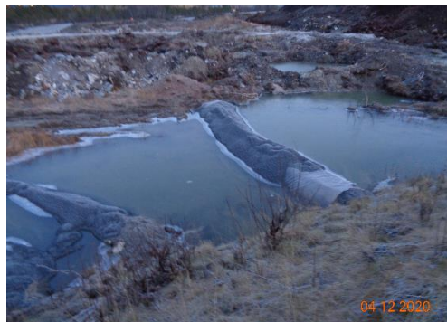
Demping av avrenning fra byggeplass gjennom sedimentasjon/flomdammer
