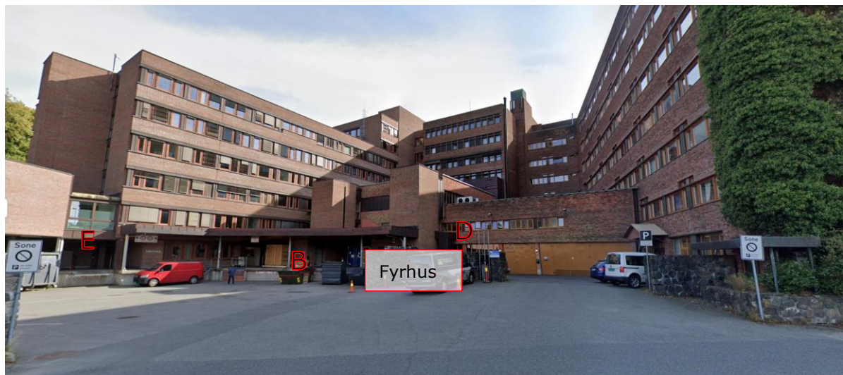
Figur 3: Fyrhus mellom Fløy E og D (Bilde fra Google maps)
