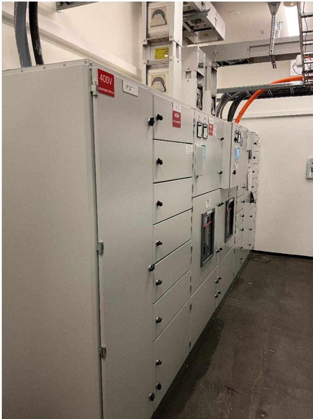
Figur 6: Eksisterende hovedtavle C-fløy, inntak 230V og 400V
