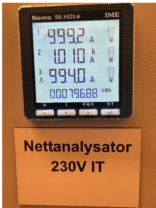
Figur 12: Eksisterende 230V hovedtavle, forbruk (A)
