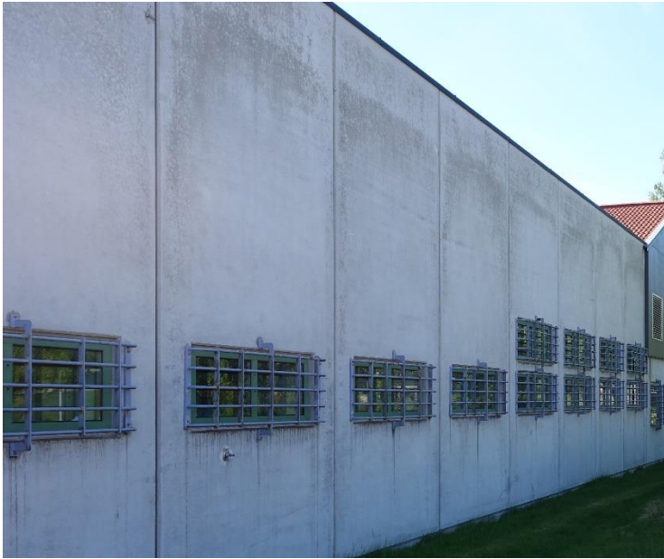
Figur 3: Vinduer med gitter på utsiden.
