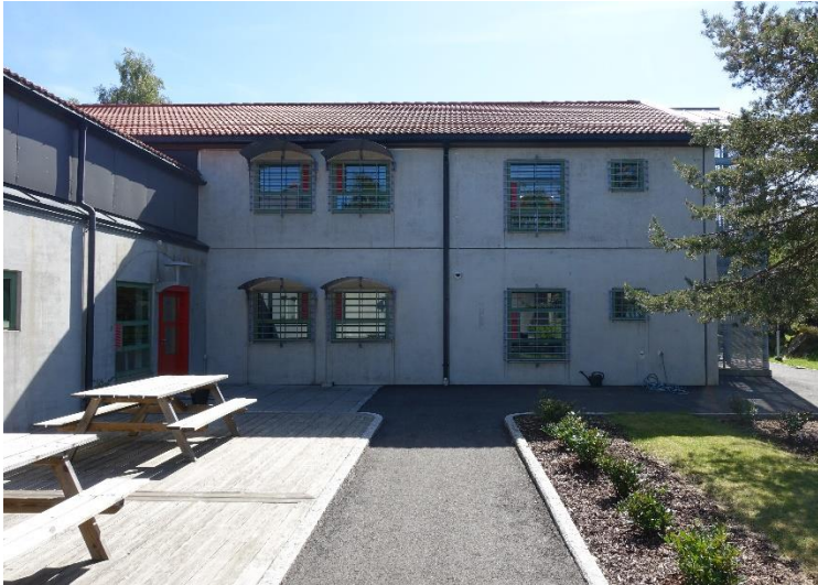
Figur 5: Vinduer med gitter og solskjerming.
