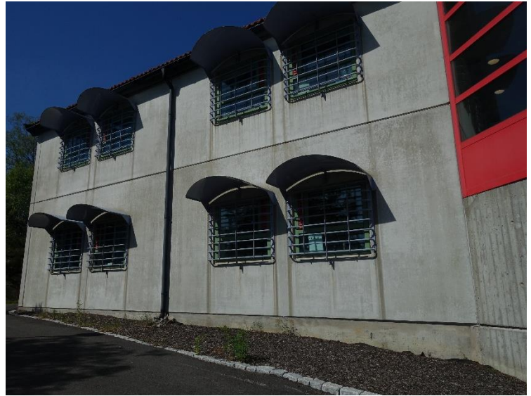
Figur 4: Vinduer med gitter og solskjerming.
