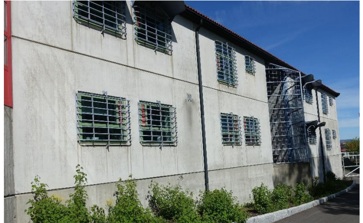
Figur 6: Vinduer med gitter.
