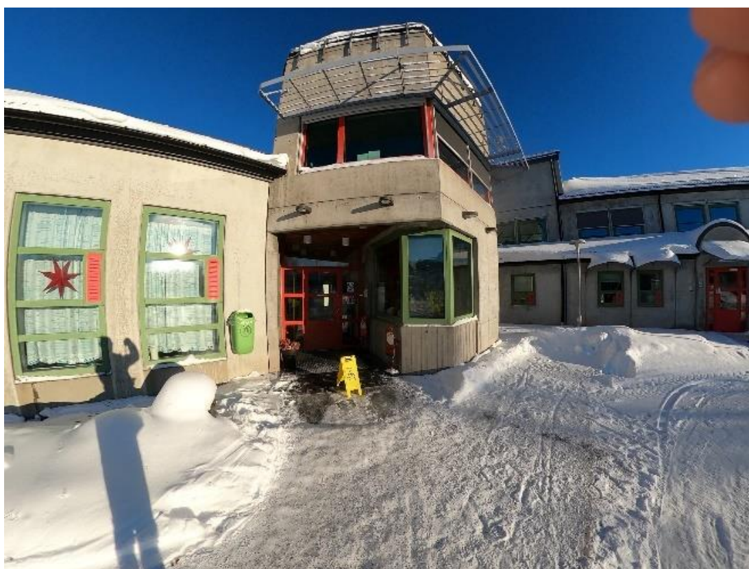
Figur 1: Inngangsparti som skal bygges om.
