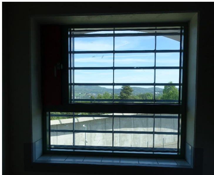
Figur 8: Bilde tatt fra innsiden av vindu med gitter.
