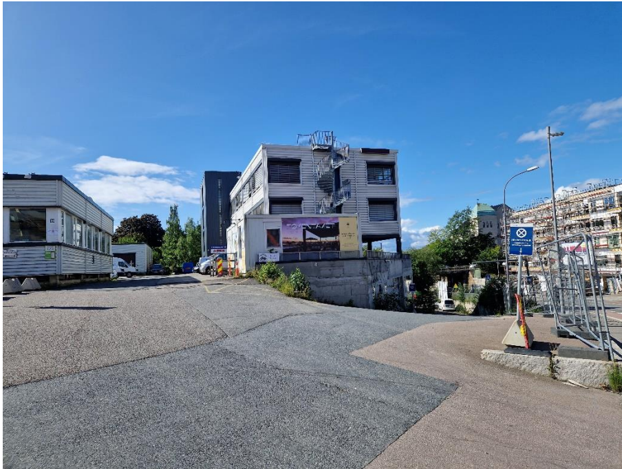
10. Ensjøveien 5 til venstre og Ensjøveien 3 rett frem. Mye løpping av asfalt i området. Mulig utført grunnarbeider i flere omganger
