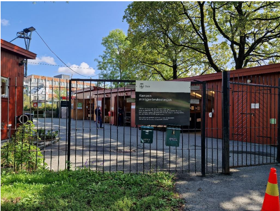
15. Mini gjenbruksstasjon, vest for Gjøvikbanen
