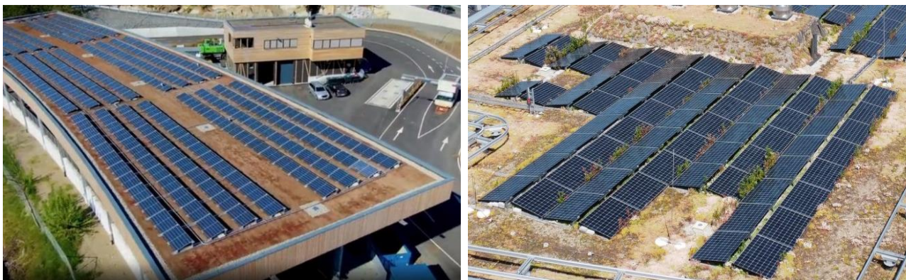
Figur 2: Til venstre er et sydvendt solcelleanlegg hentet fra Energima Solel på Ryen gjenbruksstasjon. Til høyre et øst-/vestvendt solcelleanlegg på sedum hentet fra Fusen på Orklabygget.
