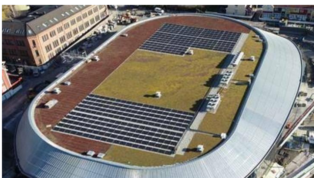
Figur 4: Et eksempel fra Jordal Amfi hvor det er områder med solcelleanlegg i kombinasjon med grønt tak.
