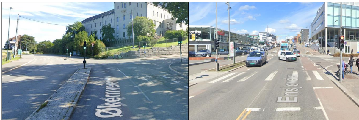
Figur 3.14: Signalanlegg med Økernveien (t.v.) og Gladengveien (t.h.) (kilde:Google Street View).
