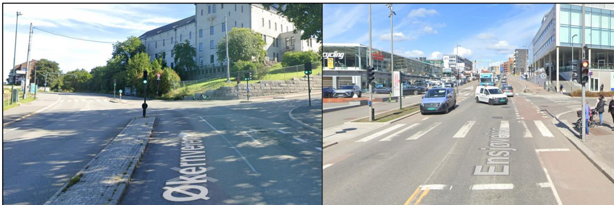
Figur 2.9: Signalanlegg med Økernveien (t.v.) og Gladengveien (t.h.) (kilde:Google Street View).
