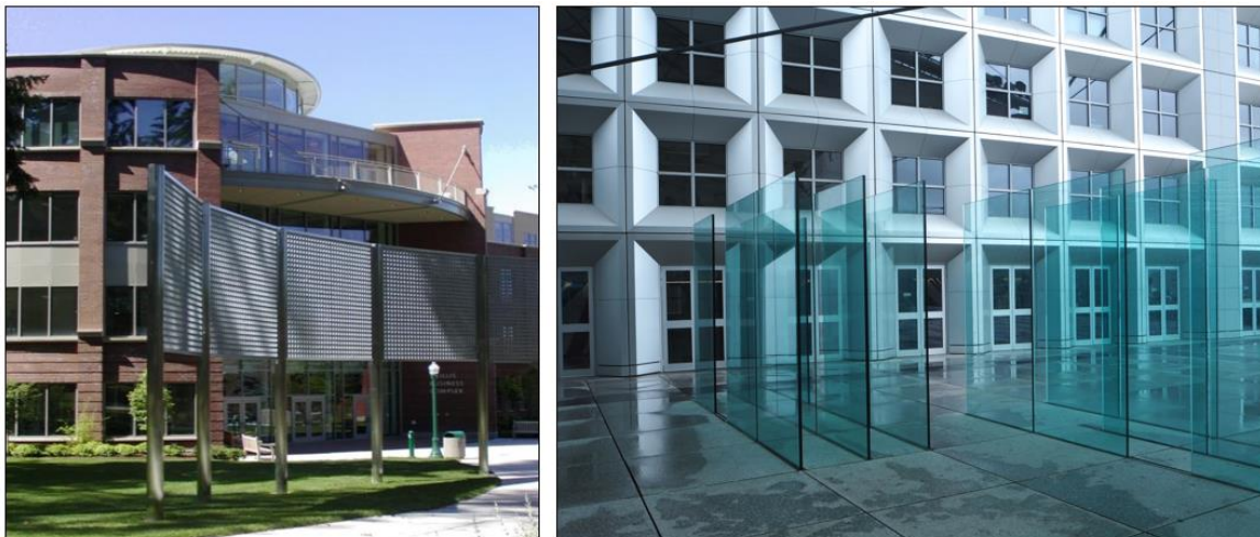
Figur 6-7. Eksempler på lokal vindskjerming av inngangsparti og utearealer ved fasade.
