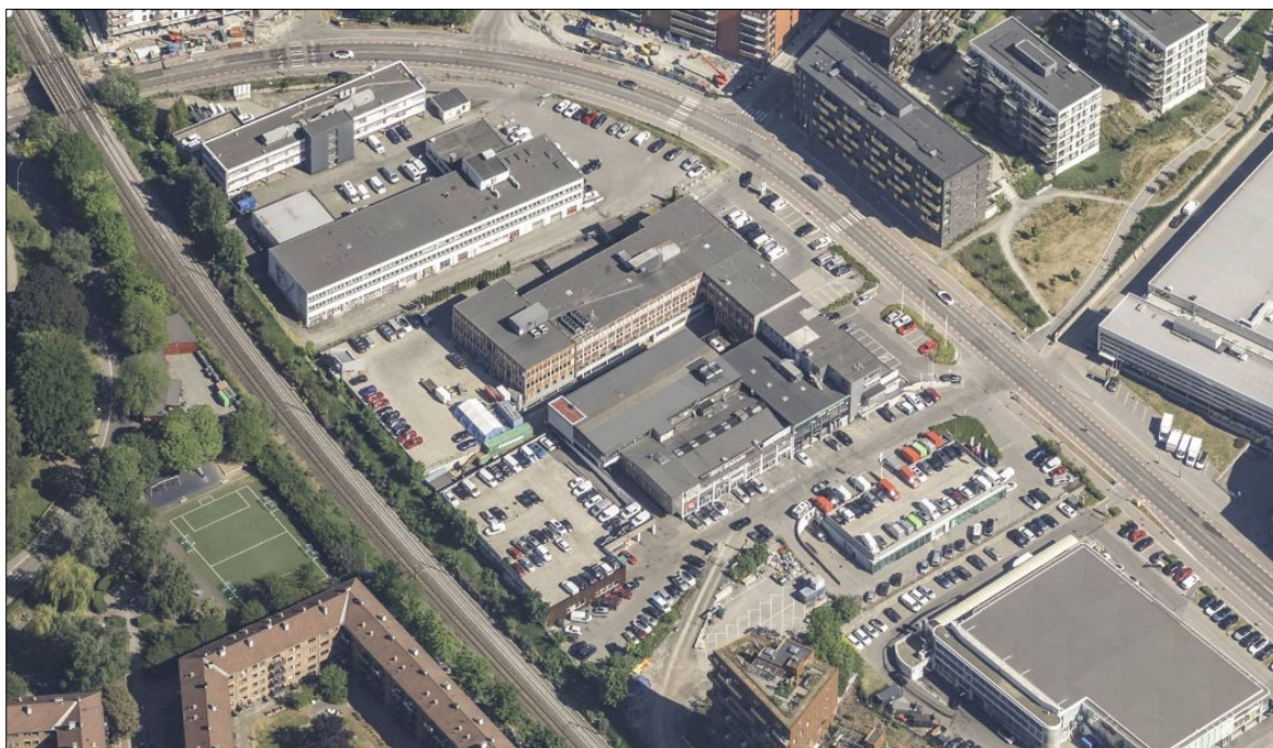
Figur 5-2. Skråfoto fra sør viser dagens situasjon med oversikt av omkringliggende bebyggelse.
