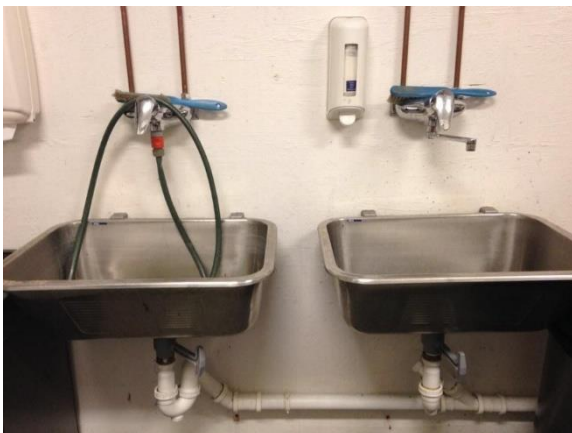
Vaskekar. Må kunne romme bløtlegging av gulvpad. Armatur med uttak for oppfylling av gulvvaskemaskin og med svingbar tut
