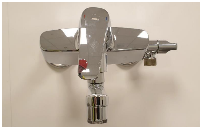
Vaskekar. Må kunne romme bløtlegging av gulvpad. Armatur med uttak for oppfylling av gulvvaskemaskin og med svingbar tut
