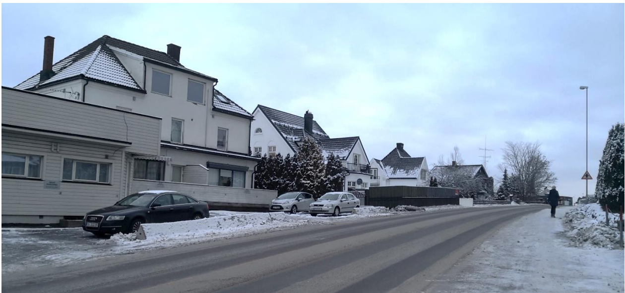
Figur 34: Deler av Gokstadveien sett mot nordøst
