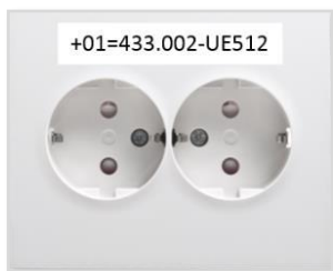
Figur 3.8.5 – Eksempel på merking av stikkontakt
