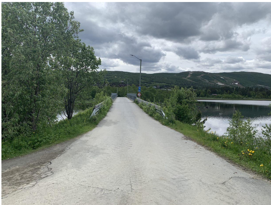
Figur 7 – Bilde av gangbro over Usteåne sett sørover fra planområdet
