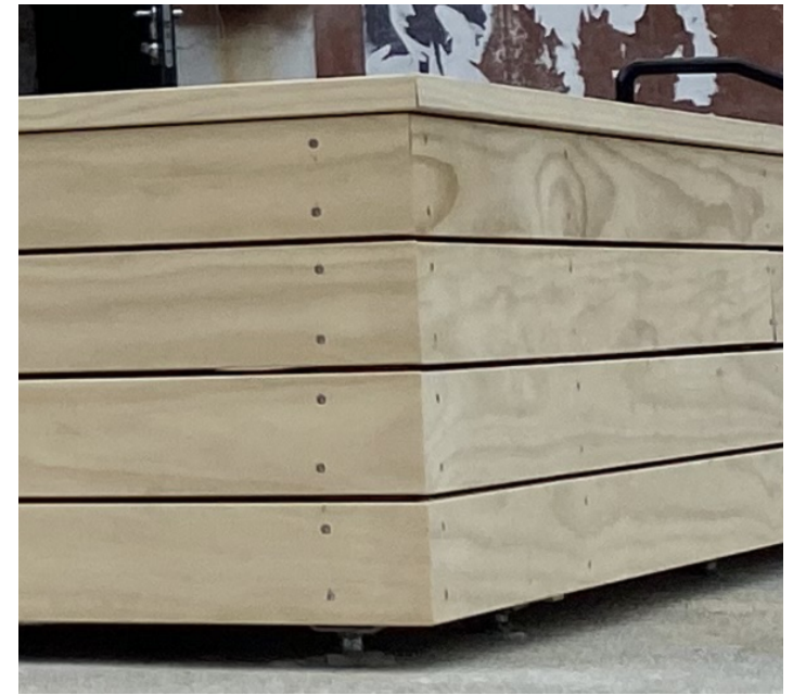
Hjørner skal skråskjæres som eksempelbildet viser. Skruer skal settes på linje.
